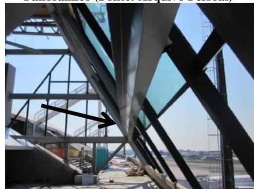
**Figura 22 – Perfil com flambagem excessiva (Fonte: Arquivo Pessoal)**
