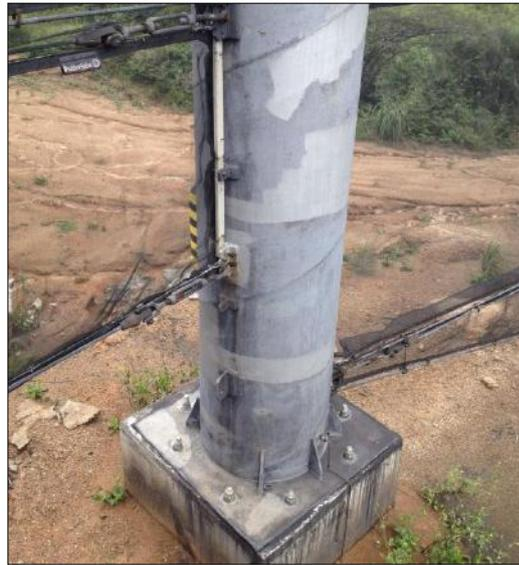
**Figura 8 – Torre 10 – Galvanizadas a fogo**
