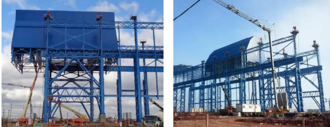
**Figura 16.** Posición inicial y final de deslizamiento.
