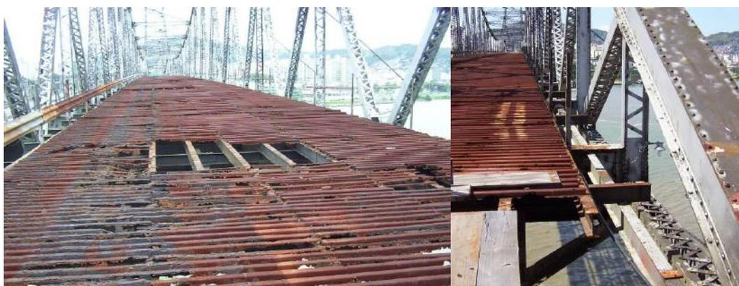
Figura 6: Elevado estágio de corrosão do tabuleiro metálico.
