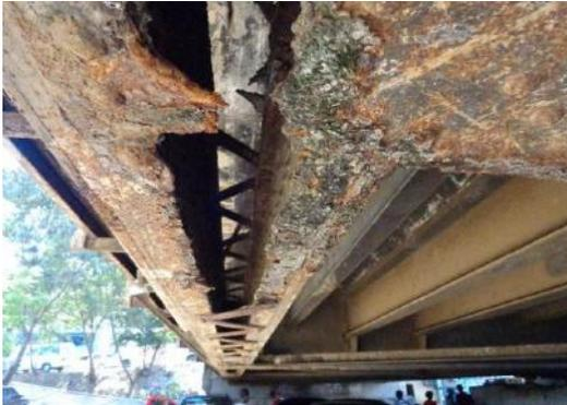
**Figura 04** - Corrosão generalizada com perda de seção
