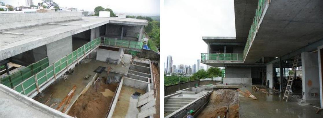
Figura 22 – Foto da estrutura frontal concluída (residência AE, balanço total com cerca de 7m)
