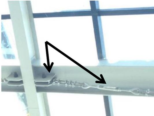
**Figura 25 - Detalhe das chapas de extremidade, conector e esticador (Fonte: Arquivo Pessoal)**
