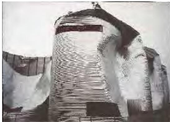
Figura 3 – Deformação na parede de silo com teto removido pelo vento (esq.)
