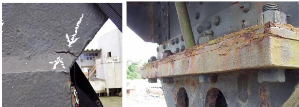
Figura 5: Fissuras e elevado estágio de corrosão das bases dos pilones.
