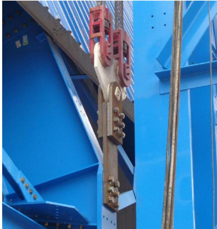
**Figura 25.** Detalle de câncamo y balancín.
