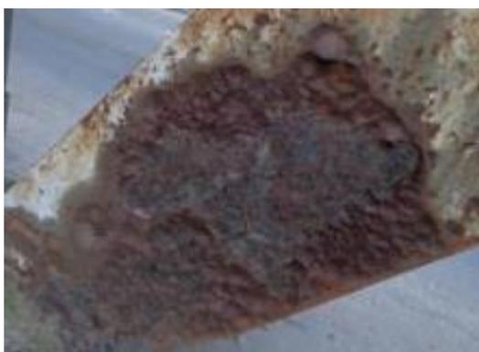
**Figura 02** - Corrosão generalizada com perda de seção
