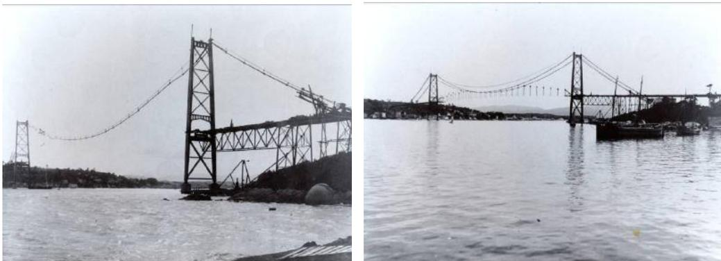
(a) Montagem das barras de olhal com cabos. (b) Montagem dos elementos isolados (treliça).
