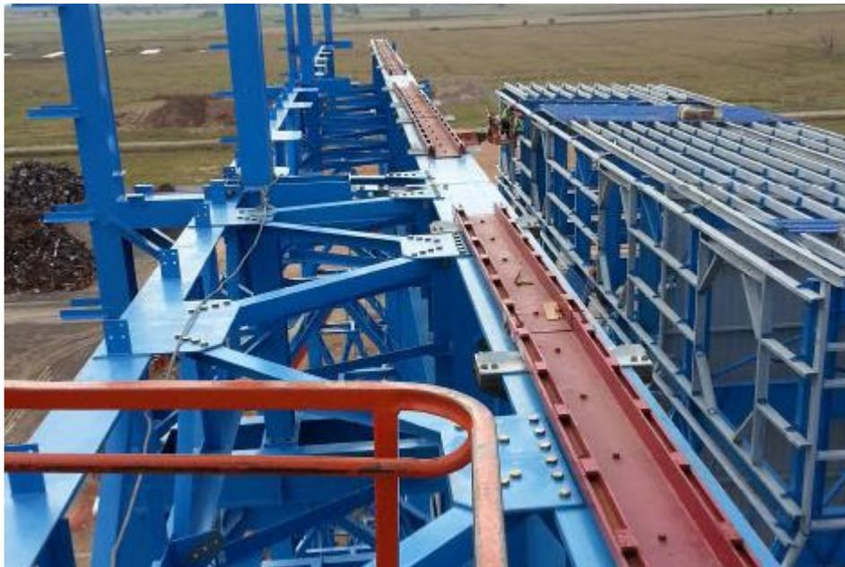
**Figura 17.** Carriles para el deslizamiento sobre viga carrilera.
