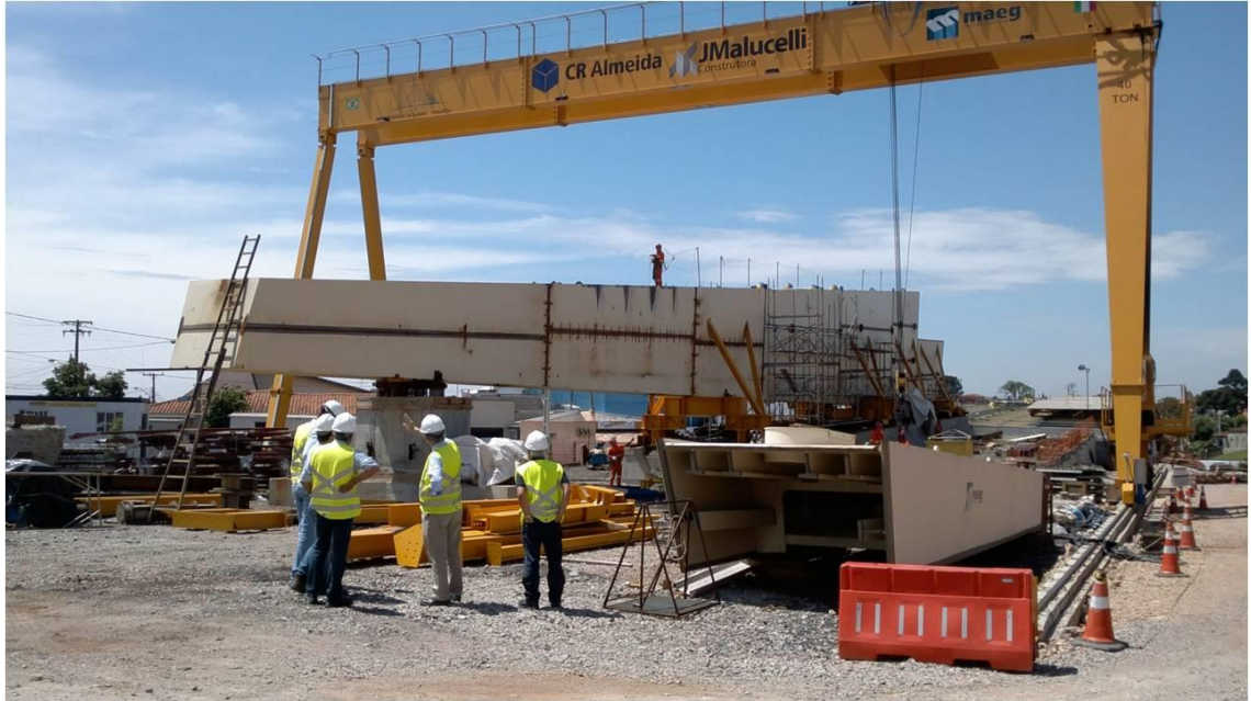
Fig.6 Montagem do mastro em horizontal, utilizando o pórtico, antes do lançamento longitudinal
