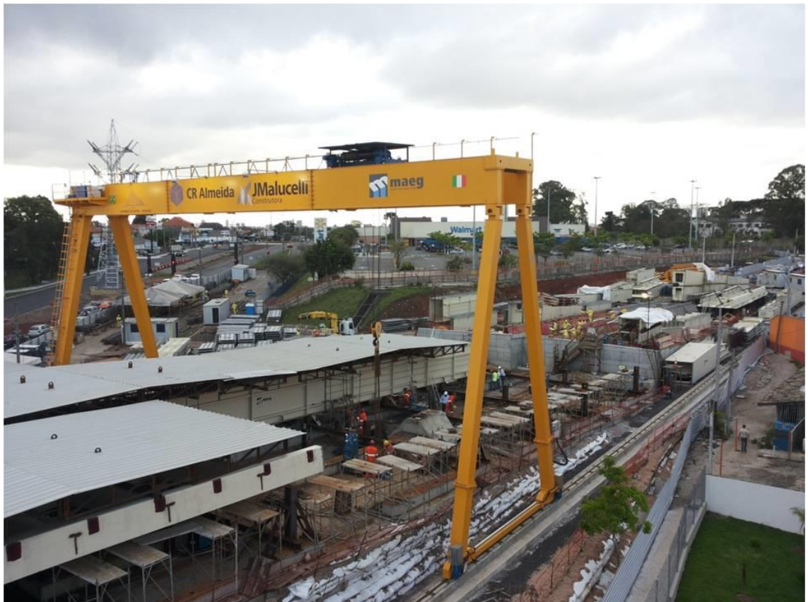
Fig. 5 Grua portico, e fases de montagem do tabuleiro metálico
