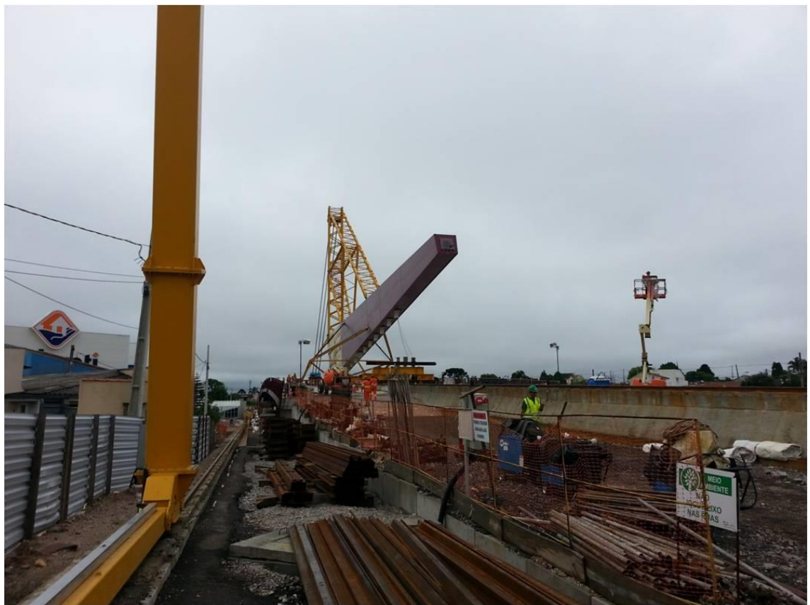
Fig. 8 Fase inicial de içamento do mastro
