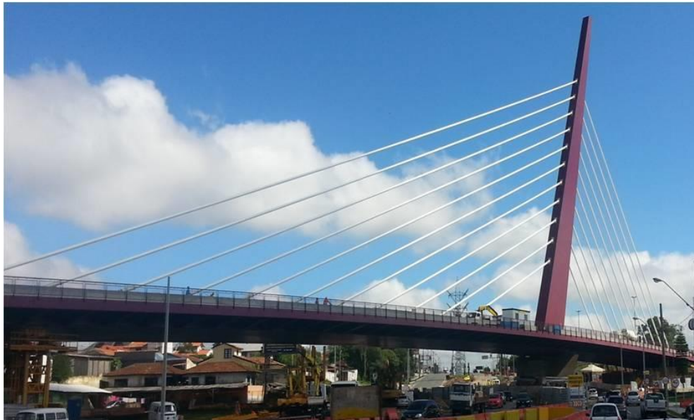
Fig. 12 Vista do viaduto estaiado no final da sua construção
