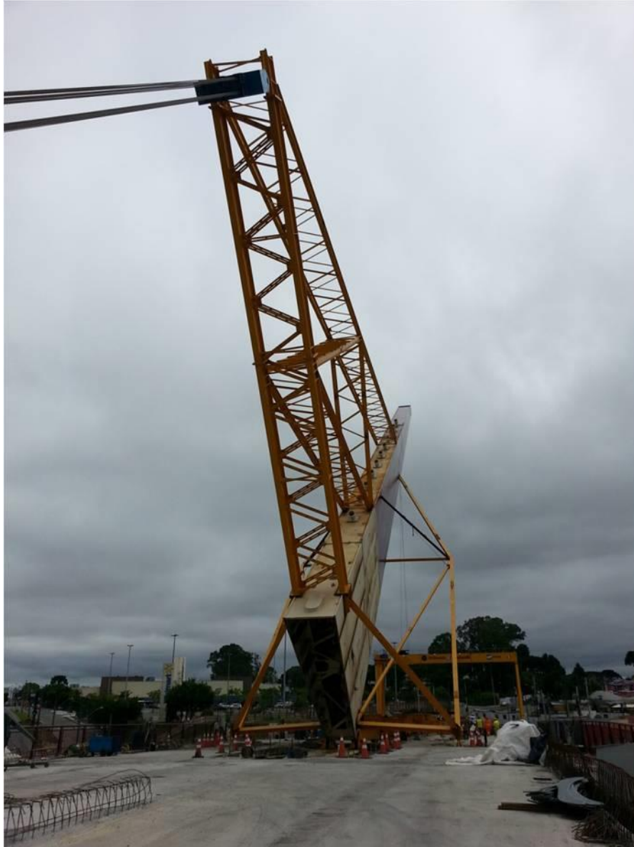
Fig. 9 Fase intermediária da rotação, e vista das estruturas auxiliares
