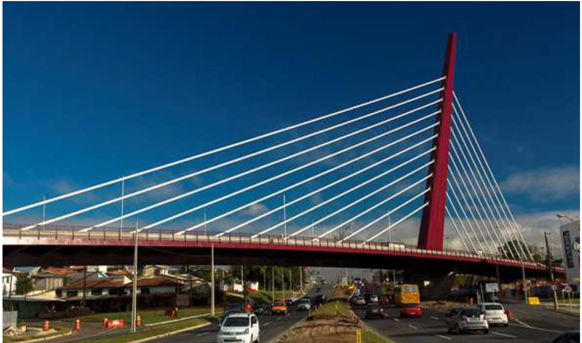
Fig.3 Vista do viaduto estaiado
