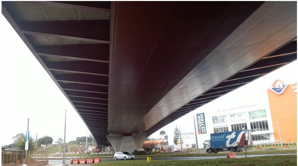
Fig. 11 Vista inferior do tabuleiro a nível da rodovia
