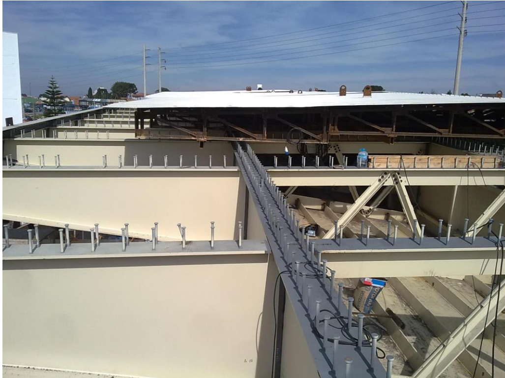
Fig.4 A estrutura do tabuleiro em fase de montagem
