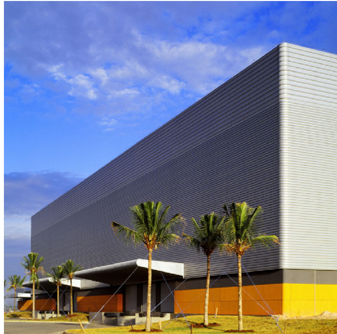
Figura 8: Perfil trapezoidal – Detalhe para a telha multidobra que envolve toda disposta horizontalmente, formando um novo revestimento de fachada, de baixa manutenção e de grande impacto visual - Entrepósito Alfandegário Aurora Eadi – Sorocaba – SP – arquiteto Cláudio Libeskind
