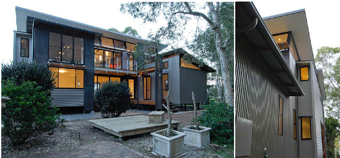
Figura 4: Residência com revestimento em telha ondulada.
