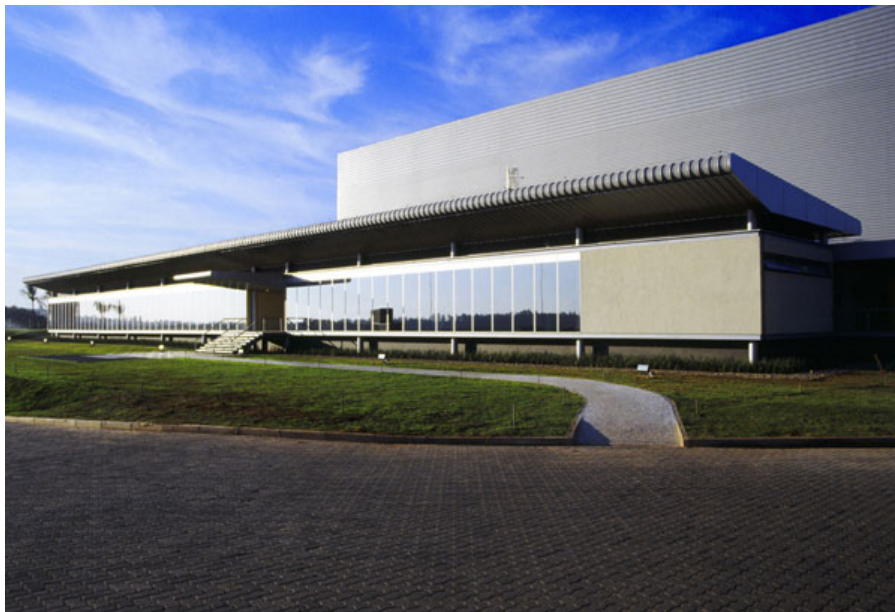
Figura 7: Perfil trapezoidal – Detalhe para a telha multidobra que envolve toda a lateral frontal da cobertura - Entrepósito Alfandegário Aurora Eadi – Sorocaba – SP – arquiteto Cláudio Libeskind Fonte: CONSTRUCTALIA
