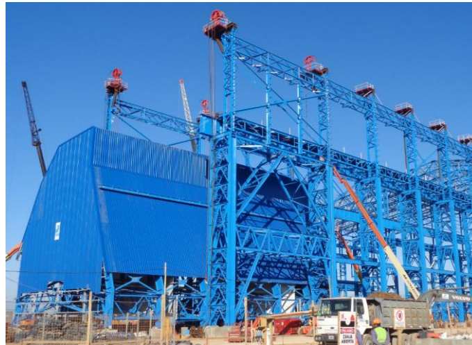
Figura 11. Ubicación de las unidades de izado. Sobre el eje 15A se usan dos unidades
