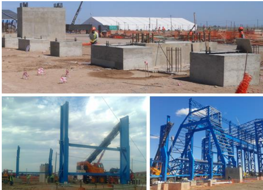
Figura 8. Etapa 1: Armado. Bases provisórias, izado de las primeras columnas y vigas.
