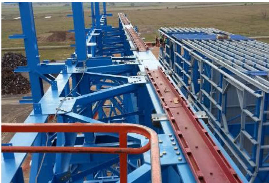
Figura 17. Carriles para el deslizamiento sobre viga carrilera.
