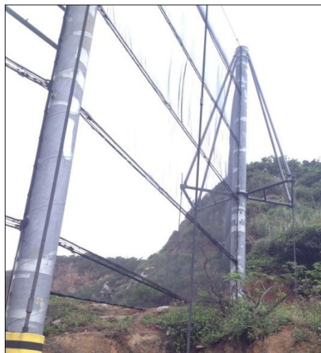
Figura 7 – Torres 09 e 10 – Galvanizadas a fogo
