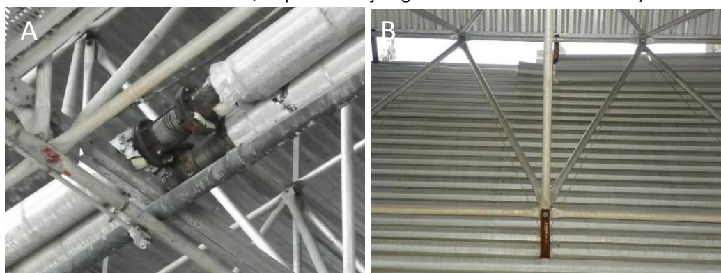
Figura 14 – Contato de metais diferentes (A- Tubos de aço em contato com tubo de alumínio; B- perfil de aço ligado na cobertura de alumínio)
