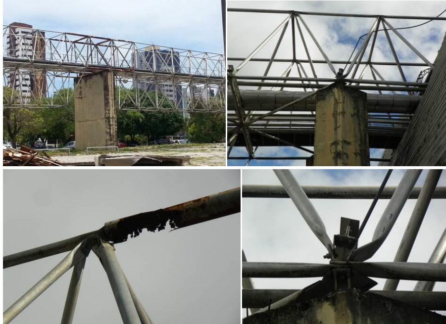
Figura 11 – Região 8 (passarela de ligação), categoria C
