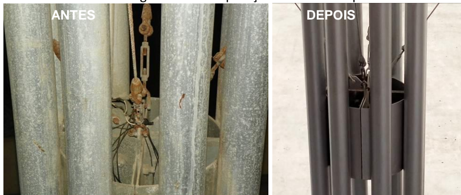
Figura 24 – Recuperação de tubos de queda
