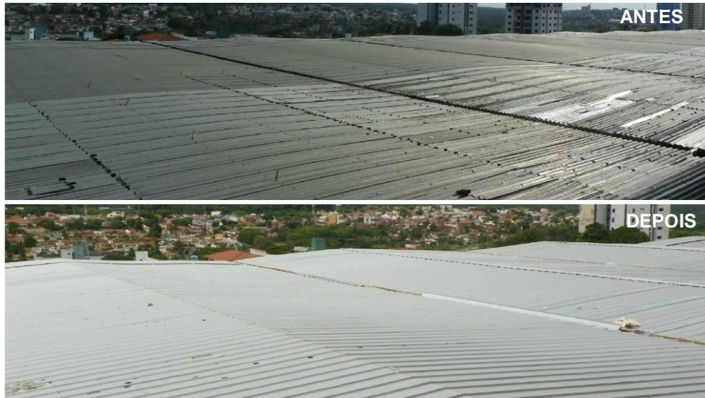
Figura 23 – Substituição de telhamento da cobertura
