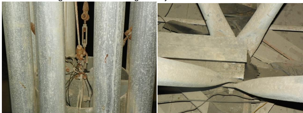
Figura 15 – Tubos de água e sujeira na estrutura
