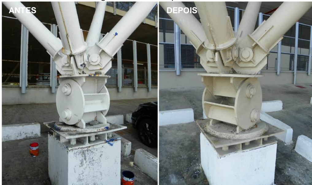
Figura 20 – Base dos pilares árvores
