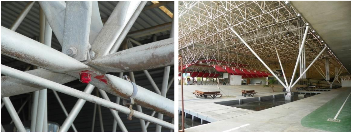
Figura 5 - Um dos nós da estrutura e pilares-árvores que apoiam a treliça espacial (fotos antes da recuperação)
