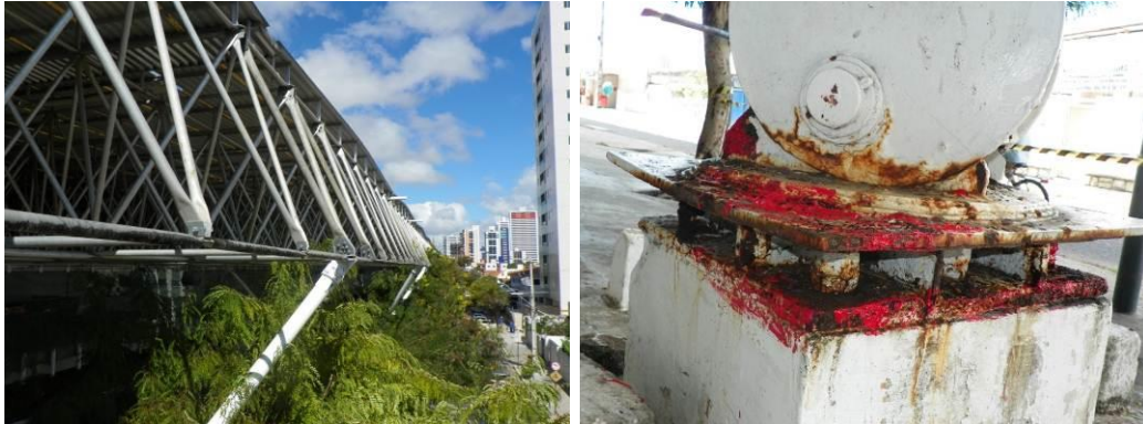
Figura 16 – Árvores em contato com a estrutura e chapas deformadas
