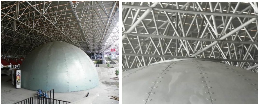
Figura 4 - Local onde havia preocupações acerca dos deslocamentos da treliça espacial: região localizada acima do planetário (fotos antes da recuperação)
