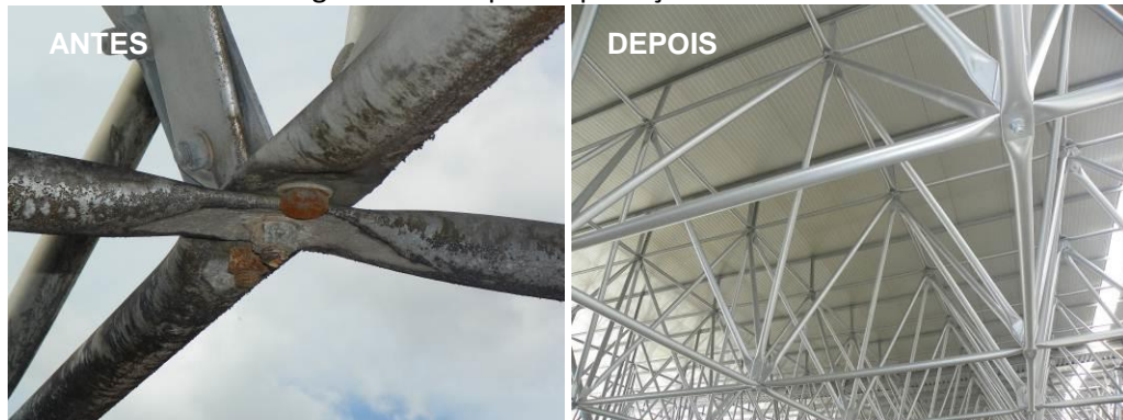
Figura 25 – Limpeza e proteção da estrutura
