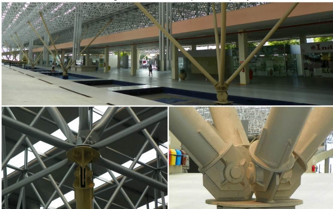
Figura 26 – Estrutura após a recuperação
