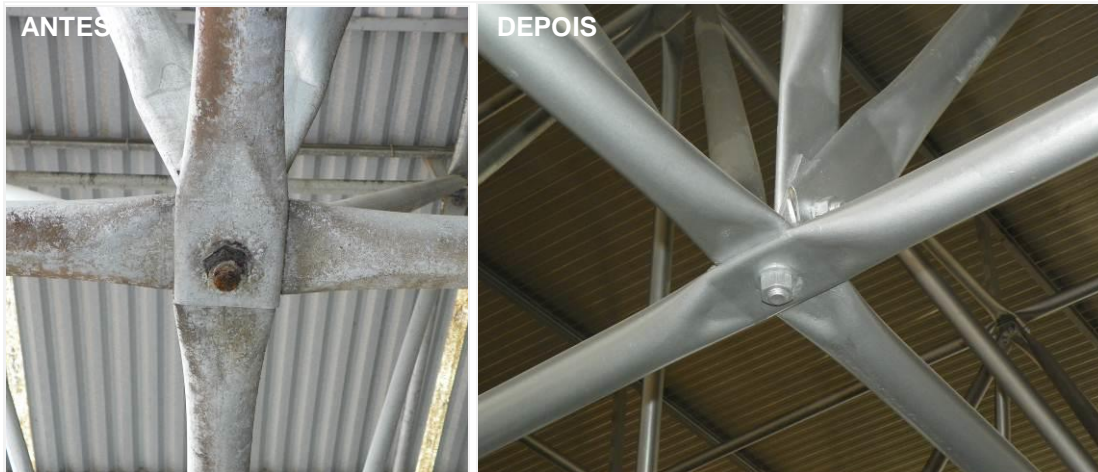
Figura 21 – Recuperação de ligação da cobertura
