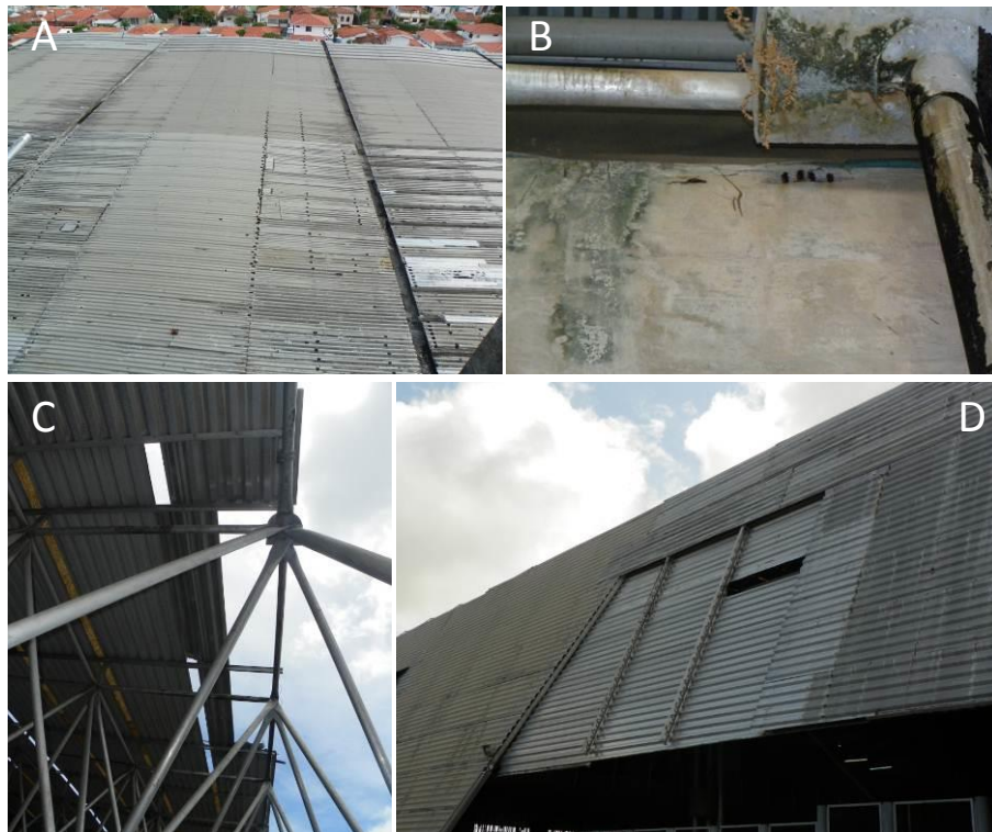
Figura 12 – Telhamento e calhas, categoria C
