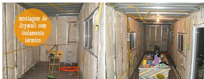
Figura 12: Isolamento térmico e acústico.
