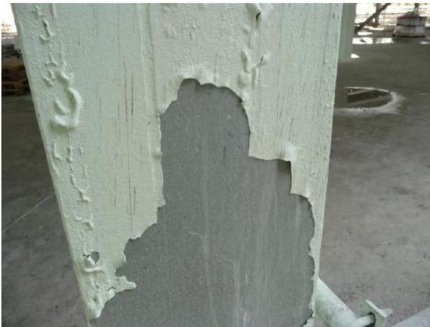
Para remediar, assegurar que a penetração de água da parte superior seja selada. A remediação é a mesma para água empoçada
