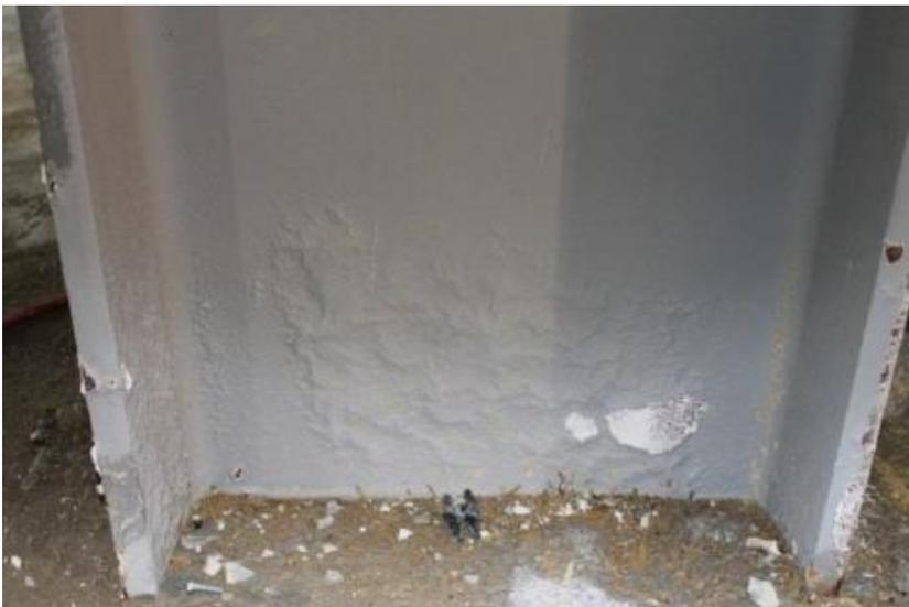
A ação de remediação seria secar a área em torno da base da coluna. Raspar a tinta intumescente desbastar, remover a poeira e resíduos e reaplicar o sistema intumescente. Essa área é muito grande para reparar com uma massa com agregado.
