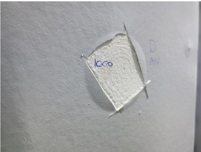
A ação de remediação seria cortar a bolha nas extremidades e desbastar e recompor o esquema de pintura.
