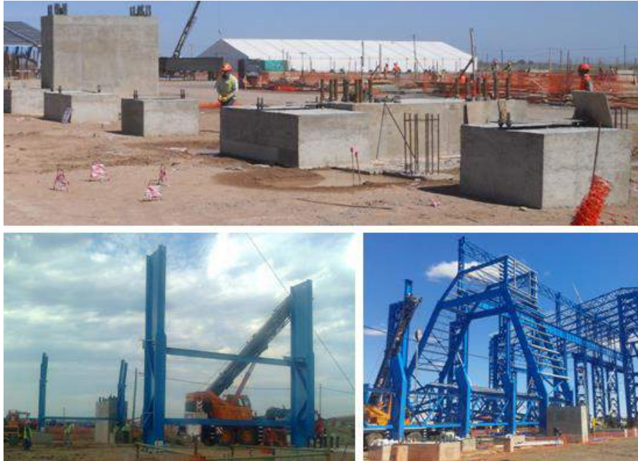
Figura 8. Etapa 1: Armado. Bases provisórias, izado de las primeras columnas y vigas.
