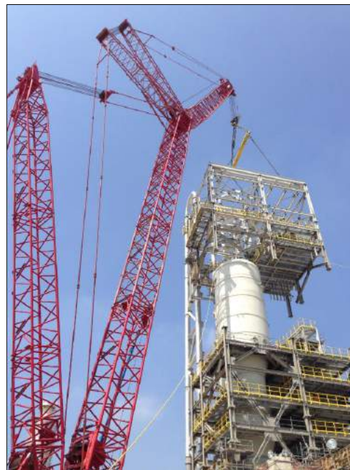
Figura 8 - Exemplo de projeto de arranjo de lingadas para içamento de um módulo utilizando grelha de içamento (esquerda). Foto da utilização deste arranjo (direita). Fonte: Arquivo da obra.
