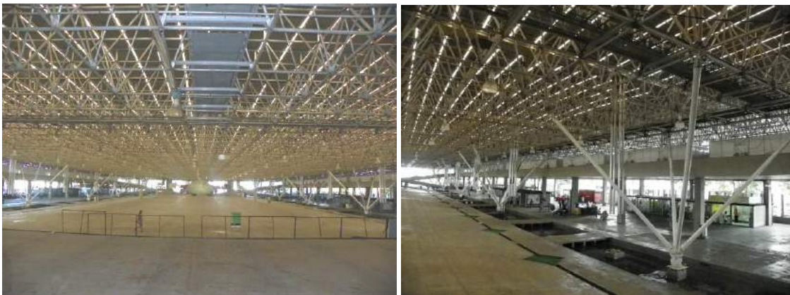
Figura 2 - Vão central da estrutura e pilares-árvores em aço apoiando a treliça espacial (fotos antes da recuperação)
