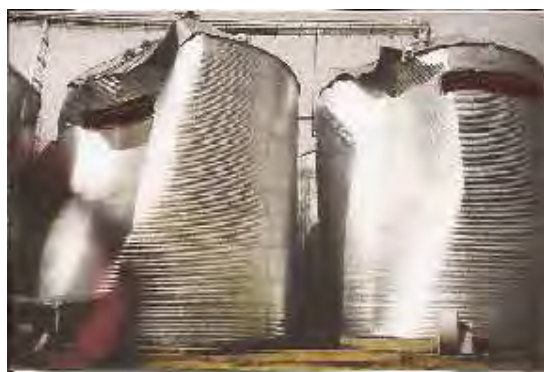
Figura 4 – Padrão de deformação de silos danificados pelo vento
