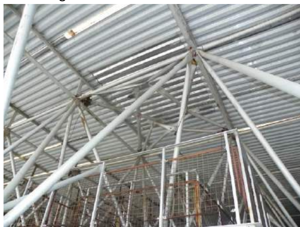
Figura 13 - Tubos desnecessários
