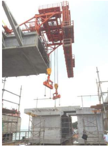
Figura 1 – Treliça içadora de aduelas.
