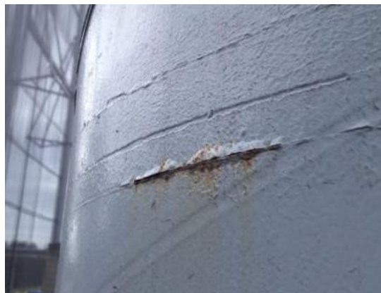
Figura 9 - Torre 06: Ponto foco de corrosão com a tinta já começando a deslocar em função da formação de óxido de ferro com maior volume
