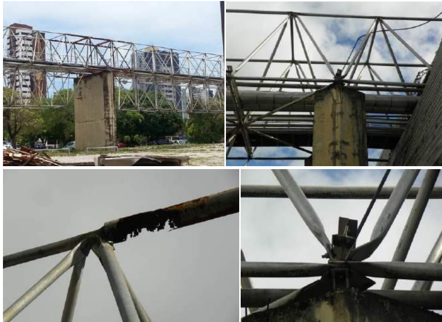
Figura 11 – Região 8 (passarela de ligação), categoria C
