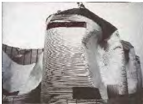
Figura 3 – Deformação na parede de silo com teto removido pelo vento (esq.)
