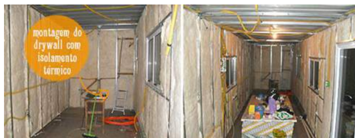
Figura 12: Isolamento térmico e acústico.
