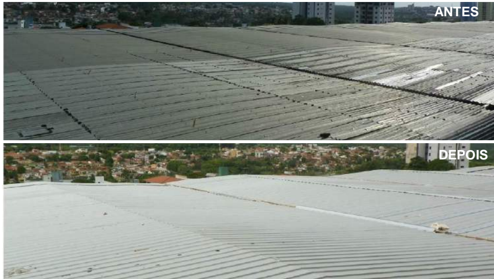
Figura 23 – Substituição de telhamento da cobertura
