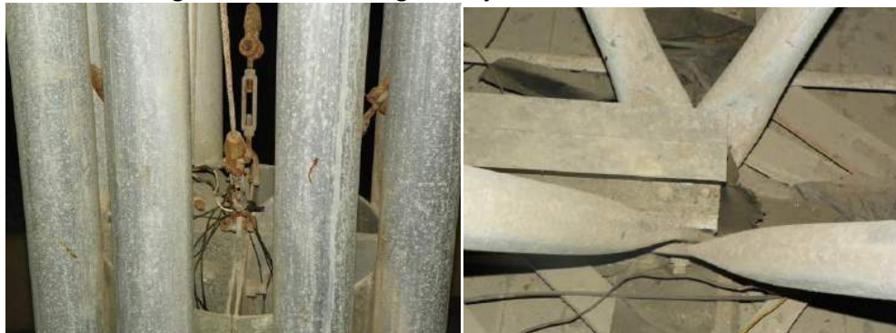
Figura 15 – Tubos de água e sujeira na estrutura
