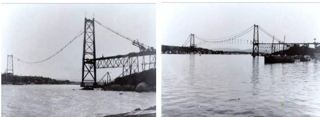
(a) Montagem das barras de olhal com cabos. (b) Montagem dos elementos isolados (treliça). Figura 3: Fotos da montagem do vão central.
