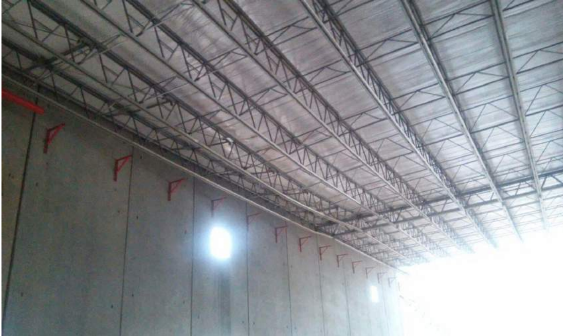
Figura 11 – Cobertura em colapso – II/IV
