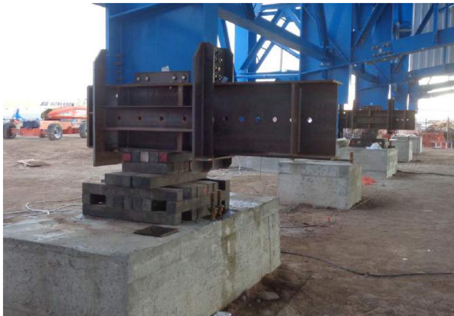
Figura 14. Esquema de las ménsulas de tope y deslizamiento.
