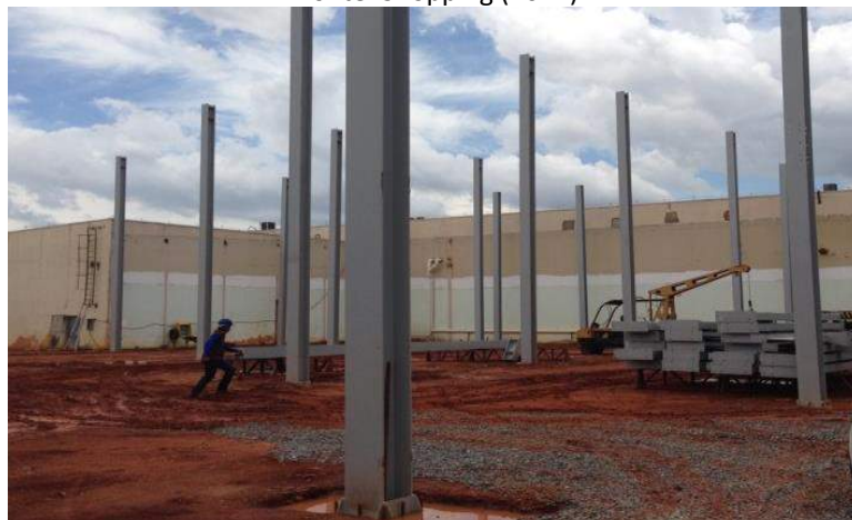
Figura 9 – Montagem dos pilares W 310x125 Fonte: Shopping (2014)
