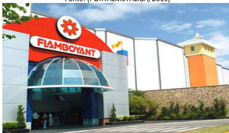
Figura 6 - Shopping Flamboyant – Goiânia Fonte: (PORTALMETALICA, 2015)
