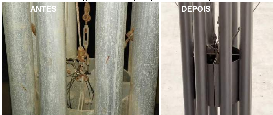
Figura 24 – Recuperação de tubos de queda
