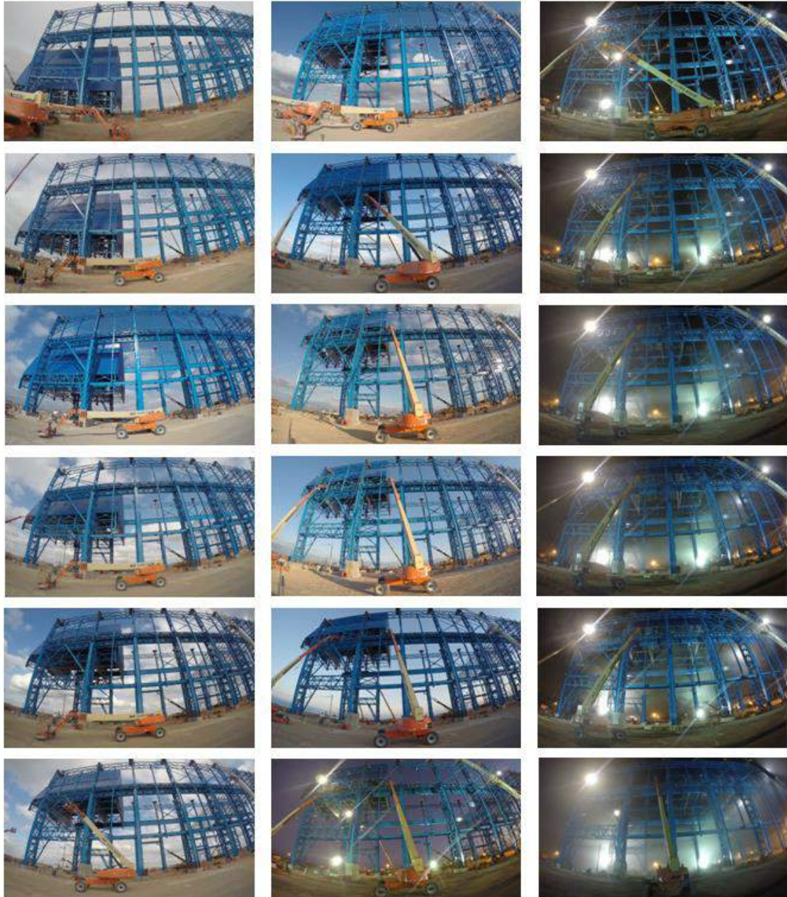
Figura 28. Sequencia de fotogr fica del montaje. Posici3n 3.
