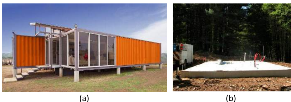
(a) (b) Figura 14: Fundações utilizadas para o assentamento de containers. Fonte: (a) Dazne [18]. (b) Residential Shipping Container Primer [13].
