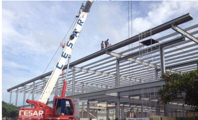
Figura 13 – Recebimento e içamento das peças Fonte: Shopping (2014)
