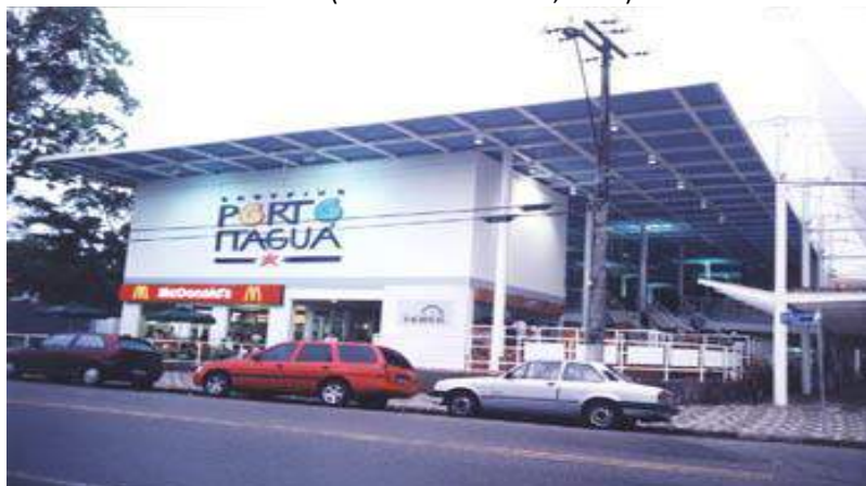
Figura 5 - Shopping Porto Itaguá – Uberaba Fonte: (PORTALMETALICA, 2015)
