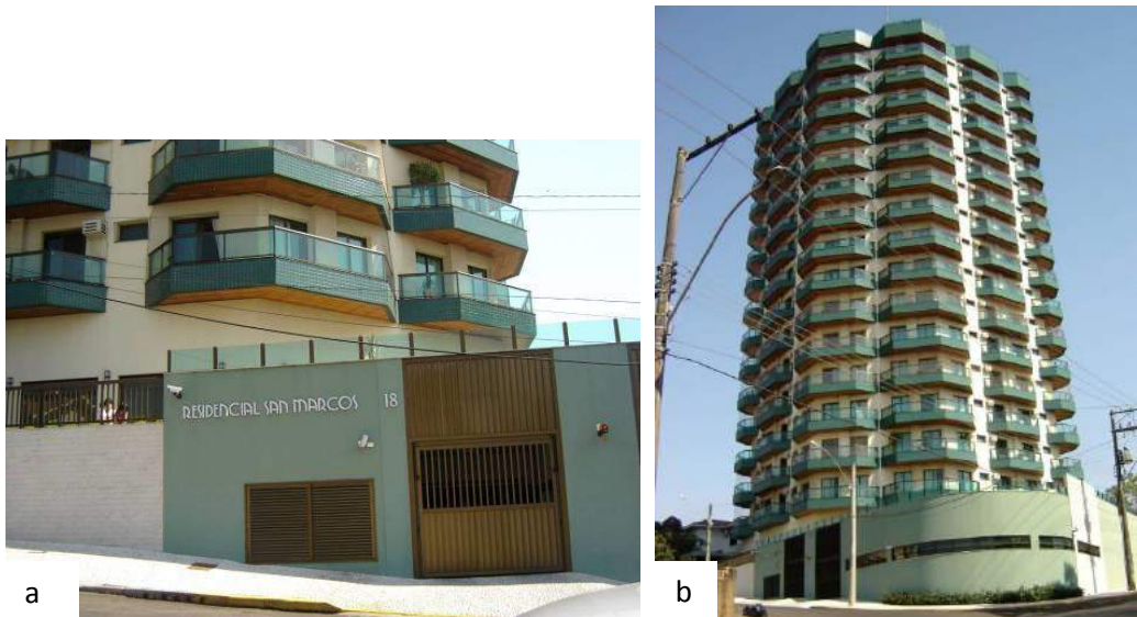
Figura 8: Edifício San Marcos: a) Parte da entrada; b) Fachada principal do edifício.
