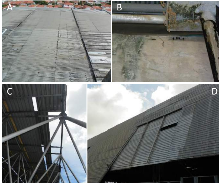
Figura 12 – Telhamento e calhas, categoria C
