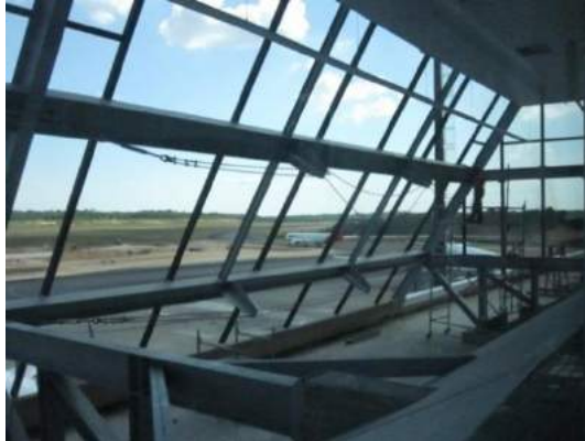
Figura 23 - Início da montagem dos cabos e chapas montantes (Fonte: Arquivo Pessoal)
