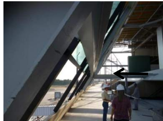
Figura 20 – Montagem da estrutura de suporte da pele de vidro do Terraço Panorâmico (Fonte: Arquivo Pessoal)
