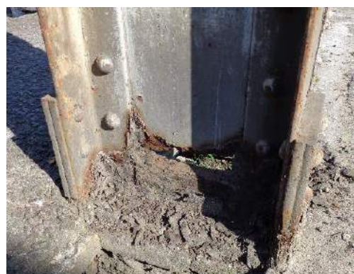
Figura 03 - Corrosão generalizada com perda de seção na interface concreto/aço
