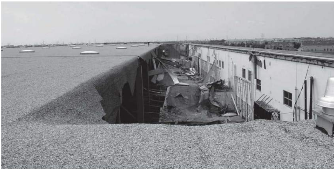
Figura 01 – Colapso parcial de uma estrutura de cobertura devido ao empoçamento.
