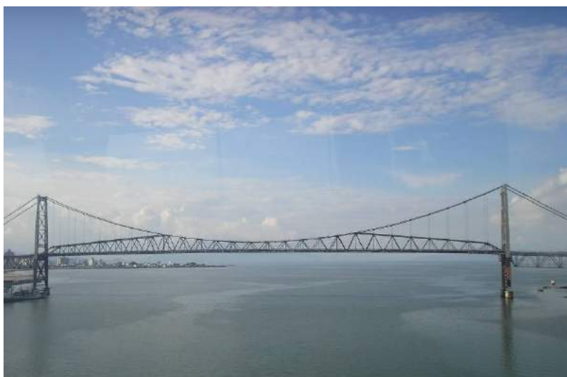
Figura 1: Vão central pênsil da Ponte Hercílio Luz, com 339,5 metros de comprimento.
