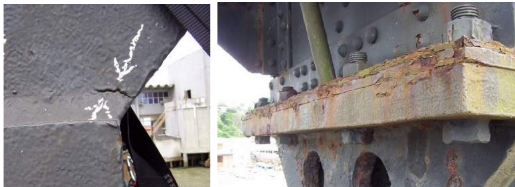
Figura 5: Fissuras e elevado estágio de corrosão das bases dos pilões.
