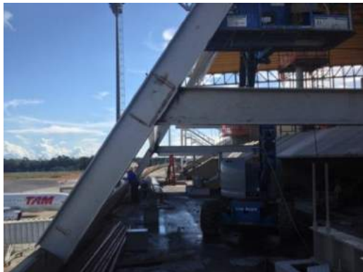
Figura 19 – Montagem da estrutura de suporte da pele de vidro do Terraço Panorâmico (Fonte: Arquivo Pessoal)
