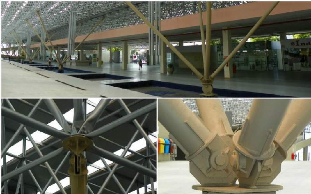
Figura 26 – Estrutura após a recuperação
