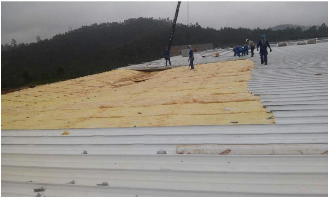
Figura 10 – Cobertura em colapso – I/IV
