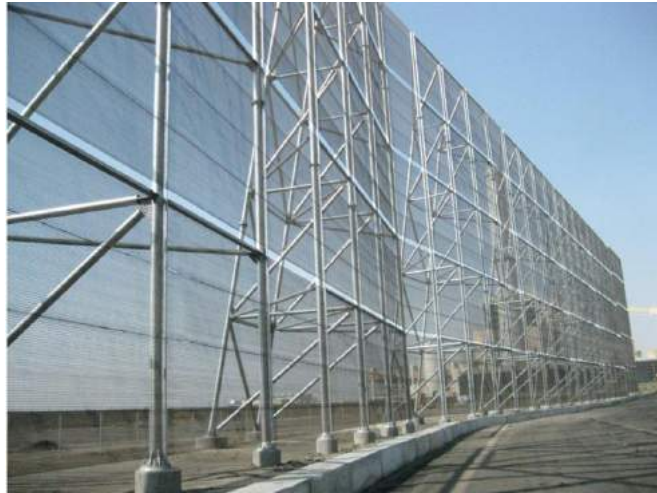
Figura 1 – Wind Fence galvanizada de proteção para pilha de carvão em Pueblo, Colorado, EUA.
