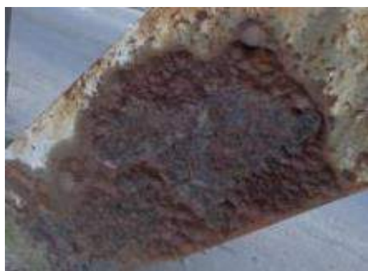
Figura 02 - Corrosão generalizada com perda de seção
