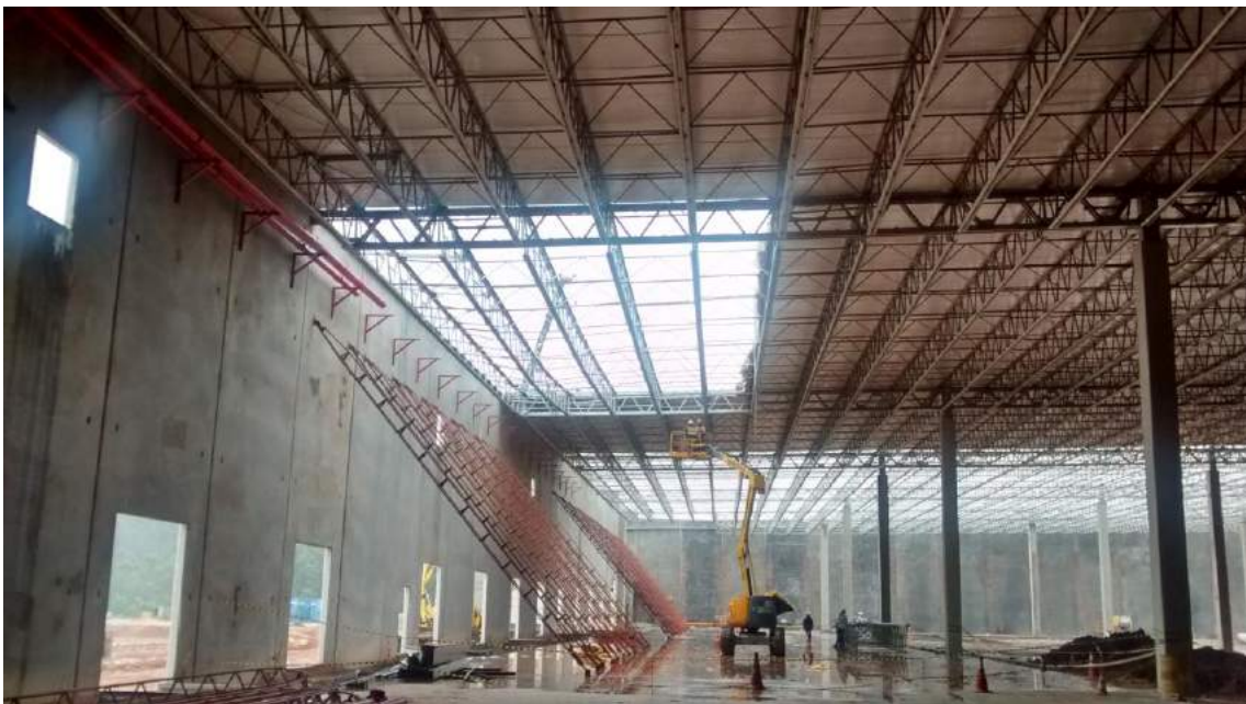
Figura 12 – Cobertura em colapso – III/IV
