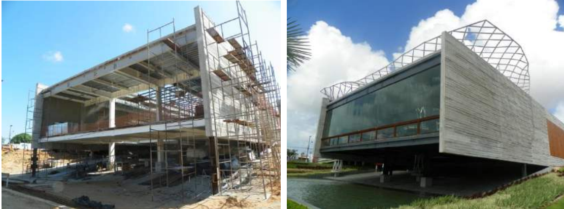
Figura 28 – Fotos do grande balanço (em execução com os pilares temporários e finalizado sem os pilares temporários)
