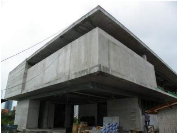
Figura 22 – Foto da estrutura frontal concluída (residência AE, balanço total com cerca de 7m)
