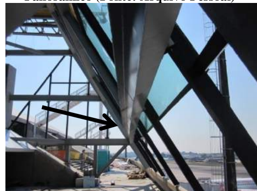
Figura 22 – Perfil com flambagem excessiva (Fonte: Arquivo Pessoal)
