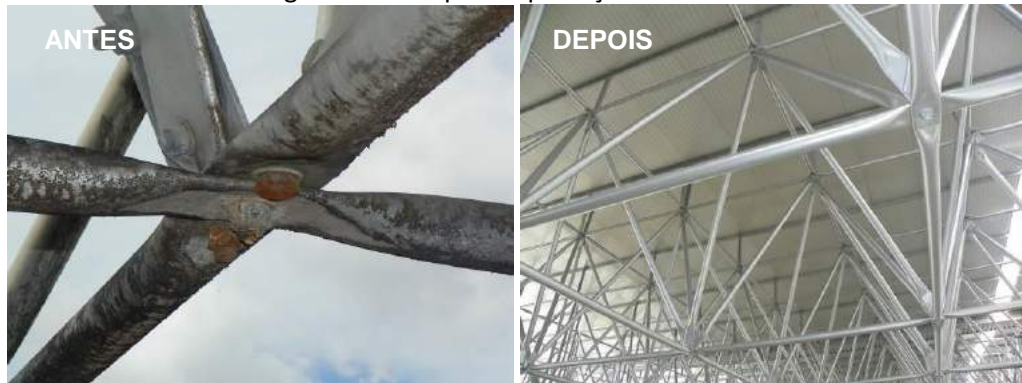
Figura 25 – Limpeza e proteção da estrutura
