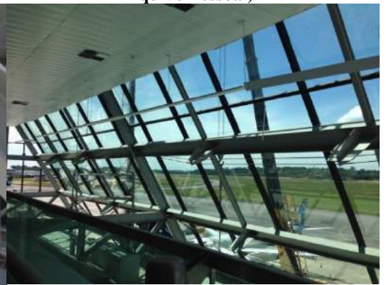
Figura 28 - Instalação dos vidros com cabos tensionados (Fonte: Arquivo Pessoal)
