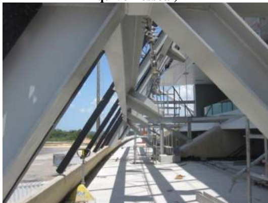
Figura 27 - Cabos tensionados e flecha corrigida (Fonte: Arquivo Pessoal)
