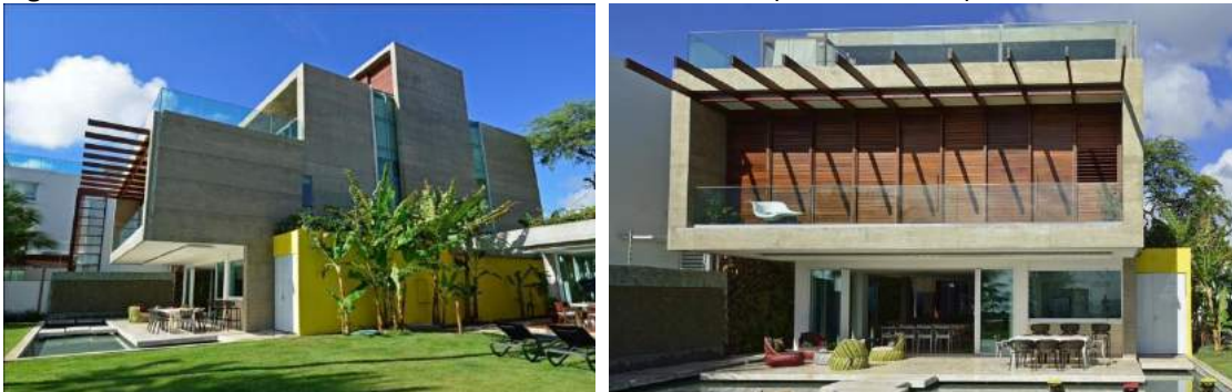
Figura 16 – Vistas frontal e lateral da residência concluída (residência LM)
