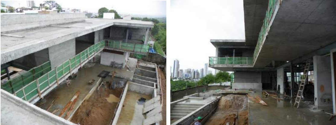
Figura 21 – Fotos da estrutura posterior concluída (residência AE, balanços de até 4.8m)
