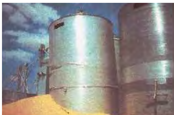
Figura 2 – Colapso de silo no carregamento (2003)
