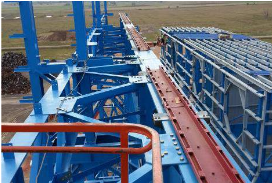
Figura 17. Carriles para el deslizamiento sobre viga carrilera.
