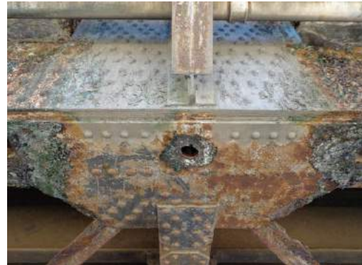
Figura 05 - Corrosão generalizada com perda de seção – causa provável de acúmulo de águas pluviais
