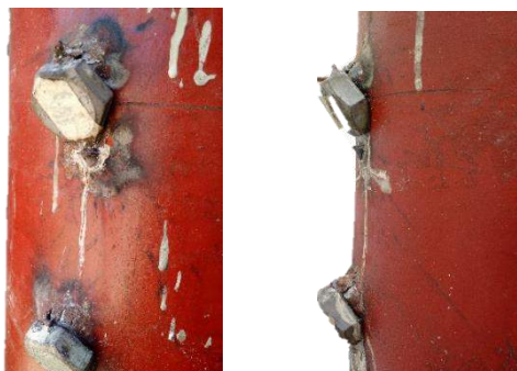
Figura 10 - Tubo de aço e cabeça do conector após a ruptura
