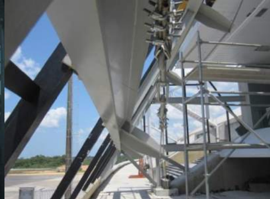
Figura 24 - Detalhe do esticador e chapa montante (Fonte: Arquivo Pessoal)
