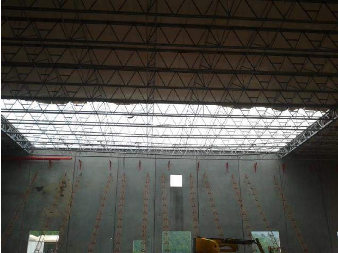
Figura 13 – Cobertura em colapso – IV/IV
