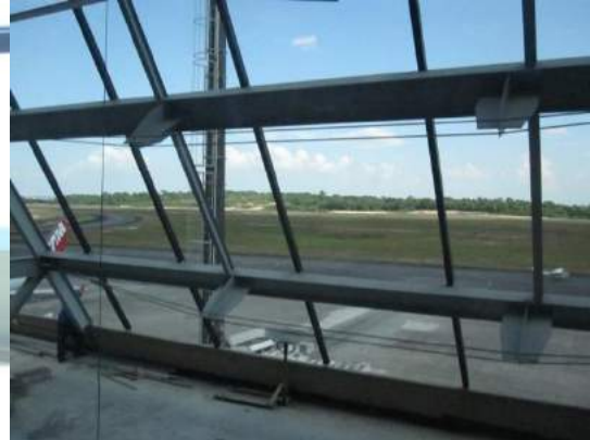
Figura 26 - Estrutura com os cabos tensionados e correção da flecha (Fonte: Arquivo Pessoal)
