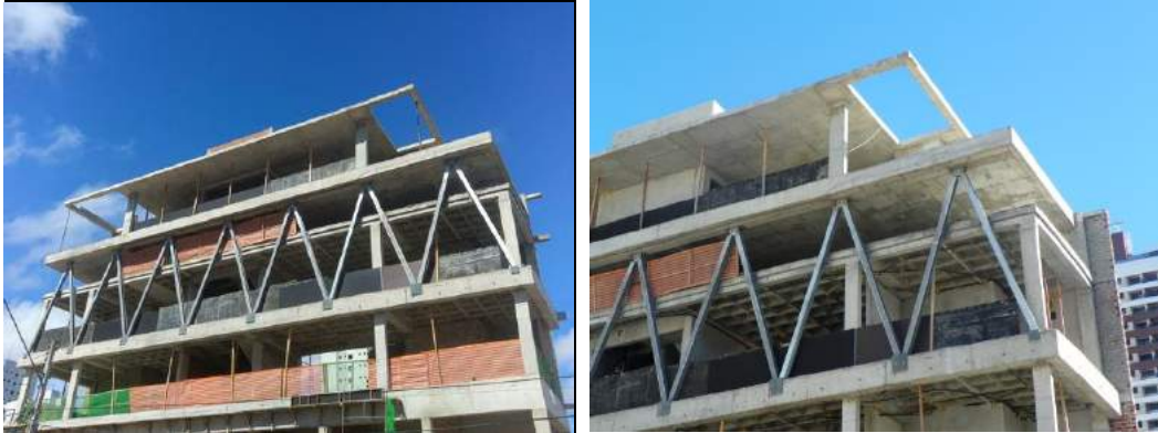
Figura 25 – Fotos da estrutura finalizada (edifício SM)
