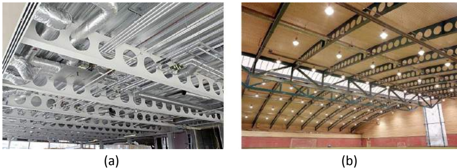
Figura 3 - Vigas alveolares aplicadas em sistema (a) de piso e (b) de cobertura (fonte: Westok [3]).
