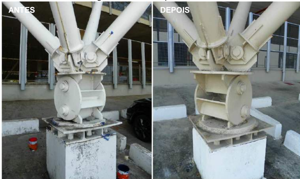
Figura 20 – Base dos pilares árvores
