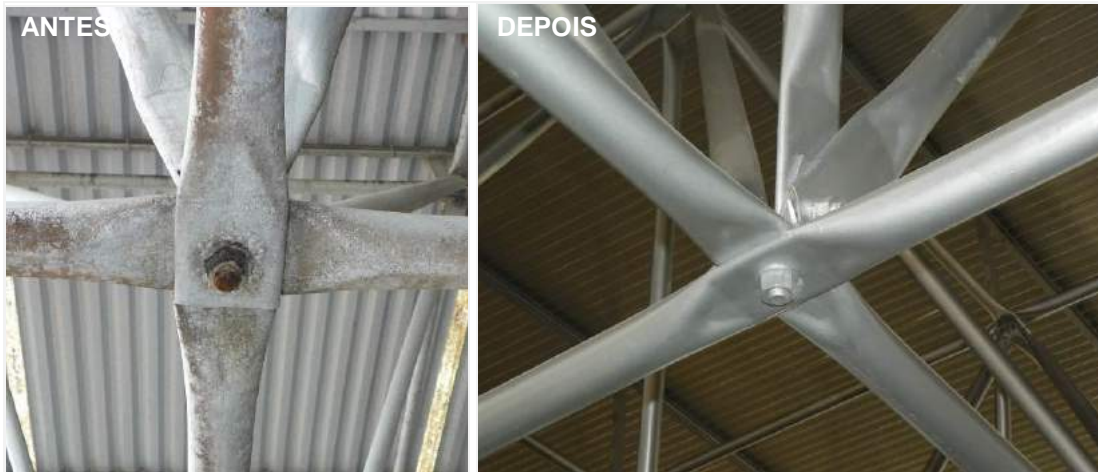
Figura 21 – Recuperação de ligação da cobertura
