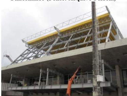
Figura 21 – Estrutura de suporte montada (Fonte: Arquivo Pessoal)
