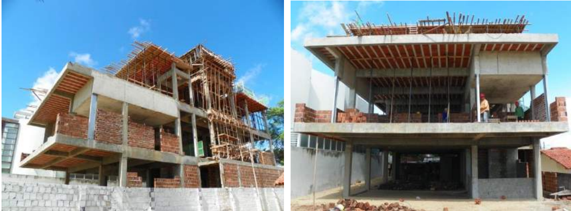
Figura 15 – Fotos lateral e frontal mostrando os tirantes de aço (residência LM)
