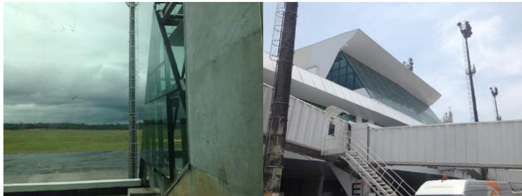
Figura 29 - Vidros laterais instalados (Fonte: Arquivo Pessoal)
