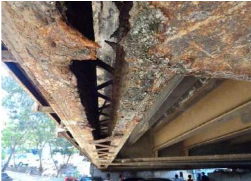
Figura 04 - Corrosão generalizada com perda de seção
