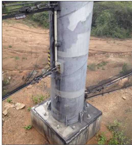
Figura 8 – Torre 10 – Galvanizadas a fogo
