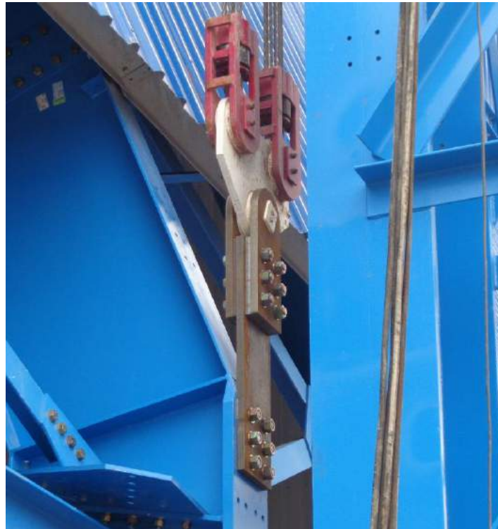
Figura 25. Detalle de câncamo y balancín.
