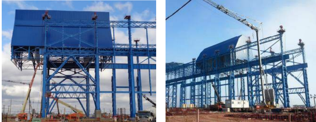
Figura 16. Posición inicial y final de deslizamiento.
