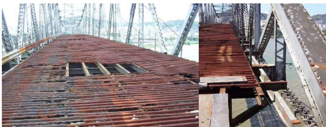
Figura 6: Elevado estágio de corrosão do tabuleiro metálico.
