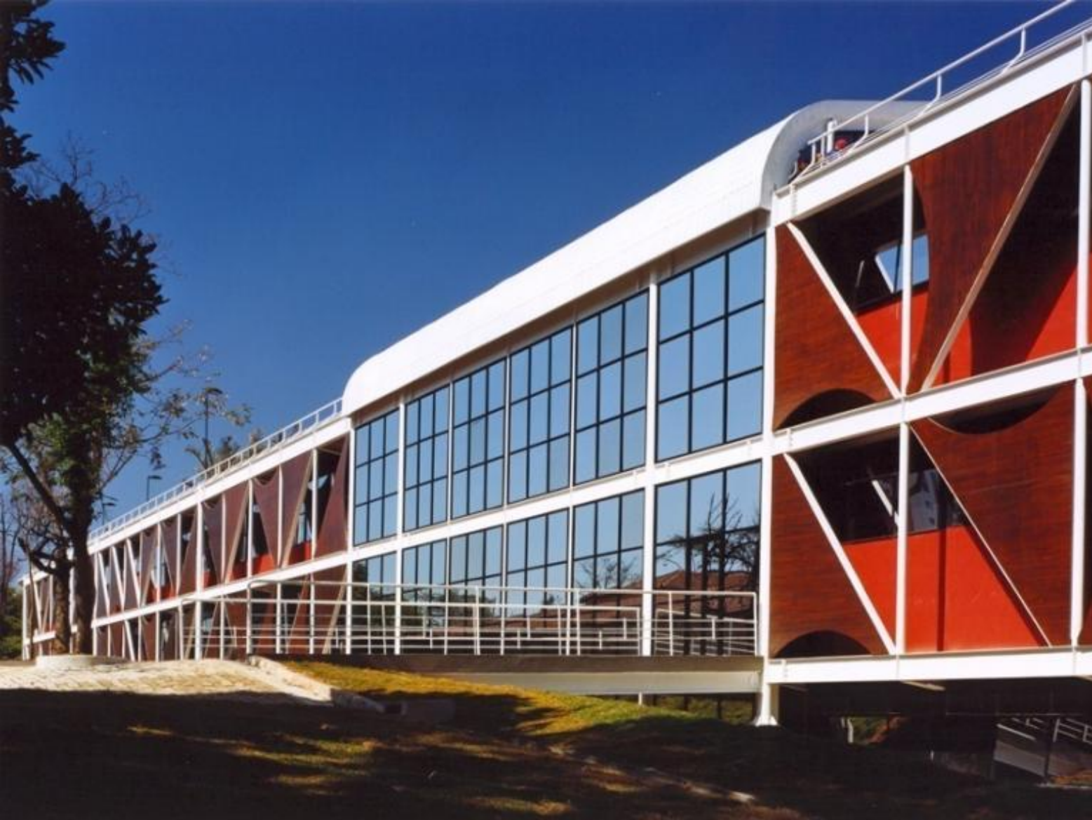
UNICSUL - Edifício Luiza de Marchi
