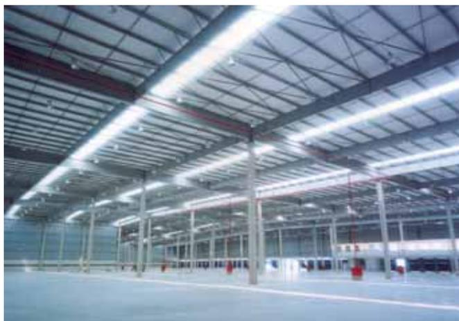
O galpão foi executado em duas águas, com pilares de concreto, e tesouras e vigas mestras em perfis "I" soldados de Alma Corrugada Senoidal, terças e tirantes em perfis de chapa dobrada. A cobertura foi composta pelo "Sistema Zipado Bemo Roof Plus" com a instalação de um lanternim tipo IVI.
