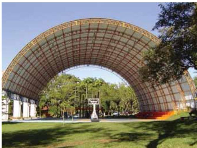
Estrutura metálica de cobertura em arco, com raio de 15,00 metros e vão livre de 30,00 metros, apoiada em pilares de concreto e viga metálica de transição.
