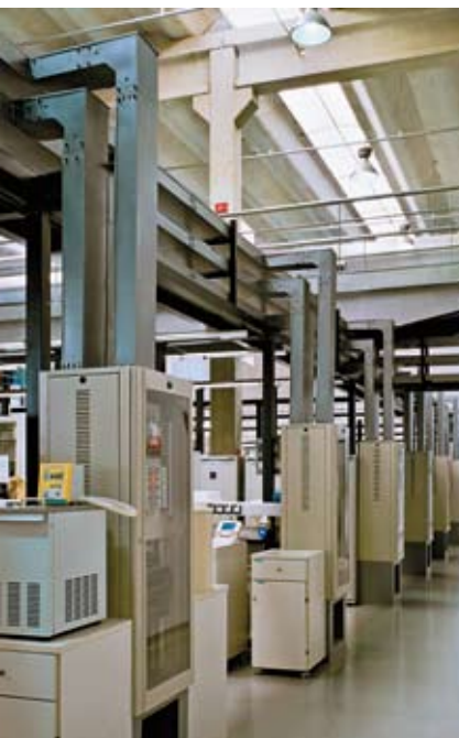
A estratégia foi implantar um cinturão em torno da construção. Os elementos pré-moldados de concreto são mantidos no espaço existente, a ampliação recorre à linguagem do galpão metálico, com estrutura, cobertura e fechamentos
