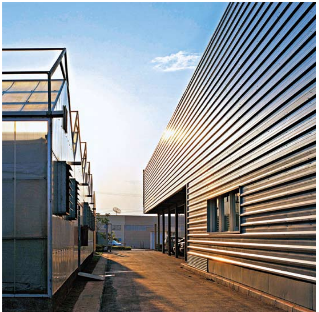
A estratégia foi implantar um cinturão em torno da construção. Os elementos pré-moldados de concreto são mantidos no espaço existente, a ampliação recorre à linguagem do galpão metálico, com estrutura, cobertura e fechamentos
