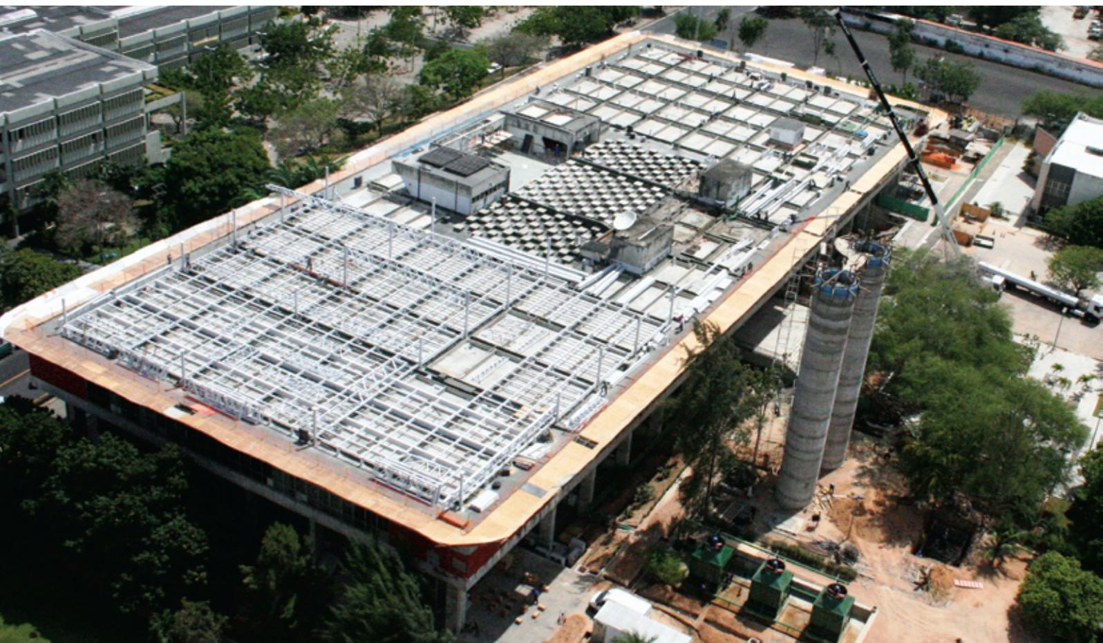
Um andar inteiro em aço foi construído sobre um edifício de concreto armado do século passado
