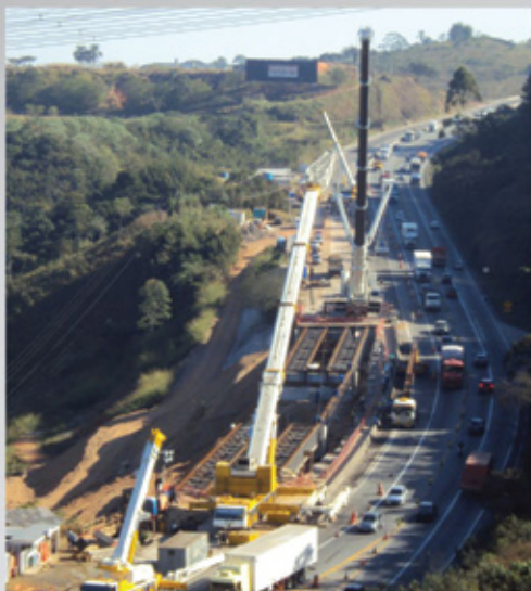
Ponte na CCR Nova Dutra - 300 toneladas
