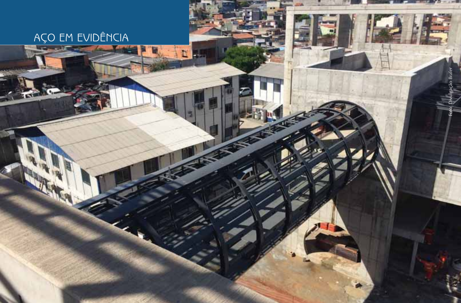
Passarela de acesso à estação em formato de túnel: estrutura metálica e vidros curvos autolimpantes
