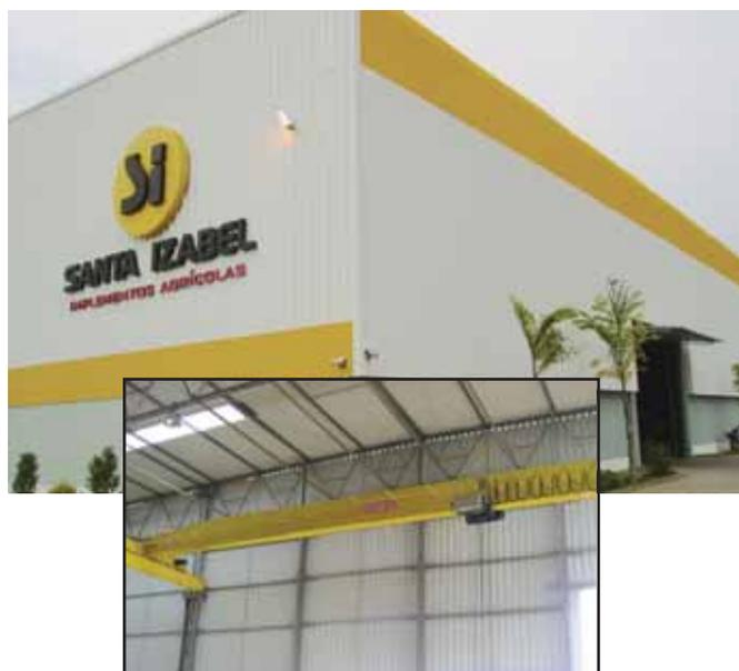
Totalmente projetada visando a pré-fabricação, a Santa Izabel Implementos Agrícolas utilizou sistemas construtivos patenteados e de rápida fabricação e montagem. A obra teve início em julho de 2006 e término em janeiro de 2007.
