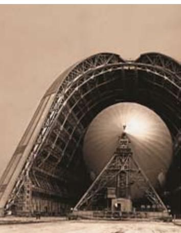
Construído na década de 1930 como hangar do dirigível USS Macon, é uma das maiores estruturas autônomas do mundo, abrangendo 32.000 m<sup>2</sup>. Sua estrutura é uma rede de vigas de aço galvanizado e é um exemplo de arquitetura moderna do século XX sendo um dos marcos históricos mais famosos do Vale do Silício na Califórnia.
