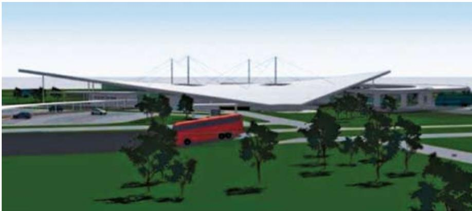
A rodoviária de Brasília é uma obra que tem toda a sua estrutura formada por treliças tubulares, suportando uma cobertura principal de 15.700 m<sup>2</sup>, com um vão livre de 50 m. A rodoviária tem três blocos, com uma área construída total de 24.900 m<sup>2</sup>.
