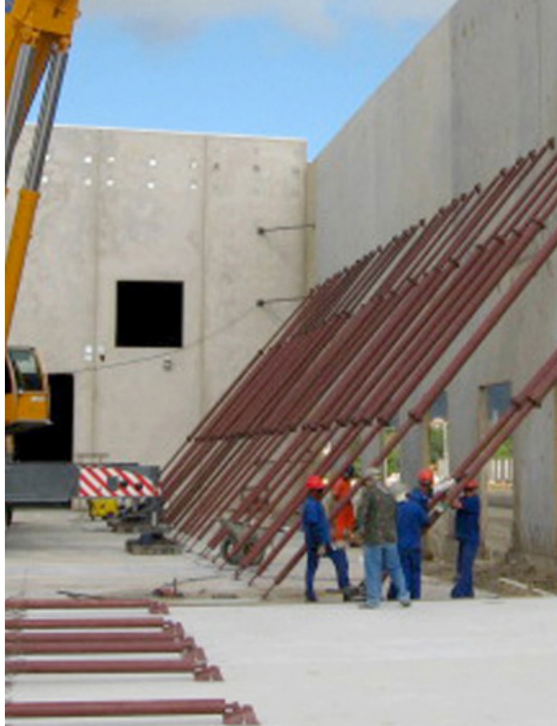
PAREDE DE CONCRETO
