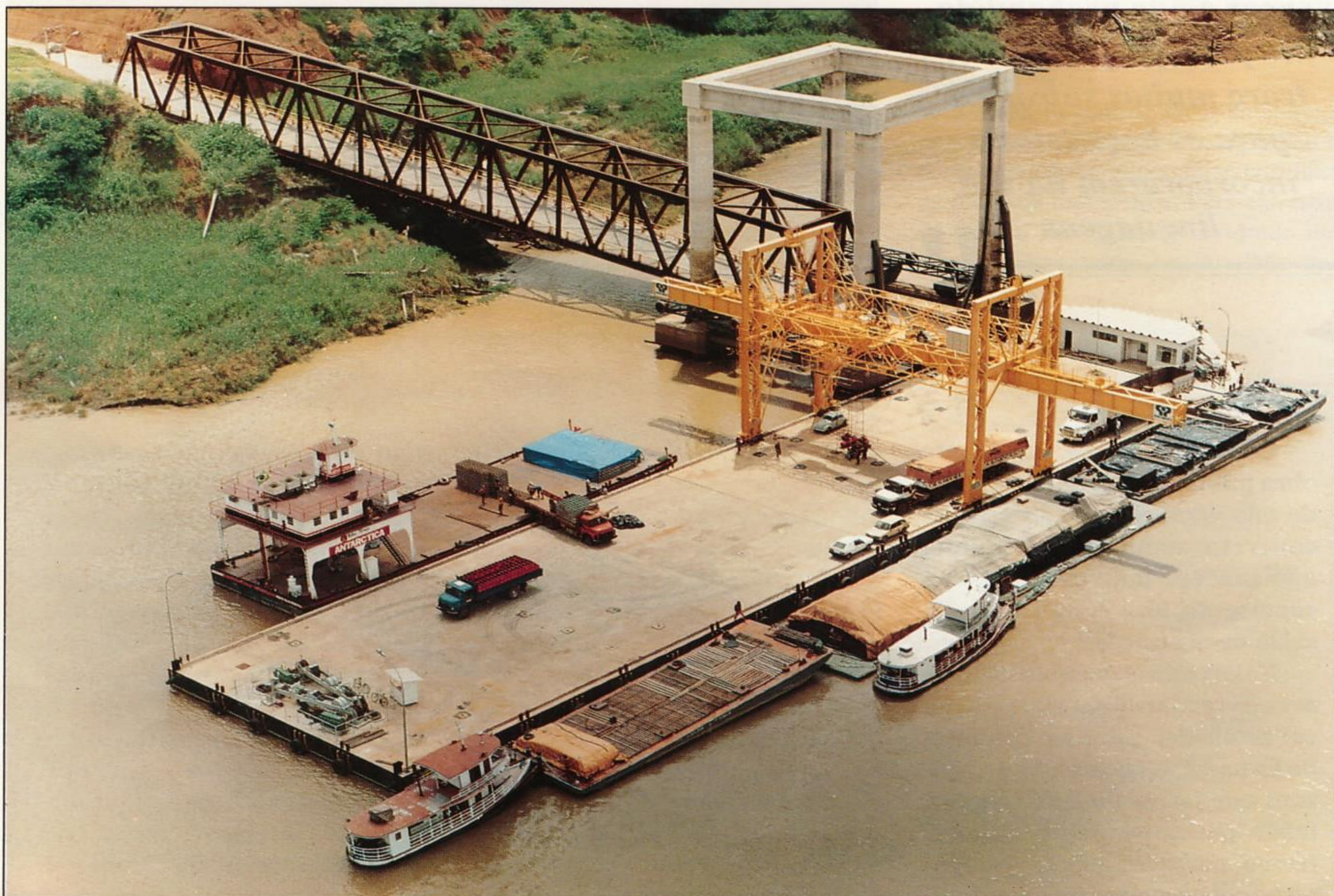
VISTA AÉREA - PORTO FLUVIAL DO RIO MADEIRA
