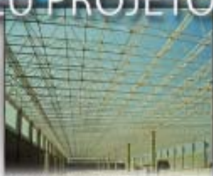
OBRA: PORTO DO PÉCÉM - CE CÁLCULO: ENG. ERNESTO CAPELO MAGALHÃES EXECUÇÃO: METAL ARTE COM IND REP LTDA
