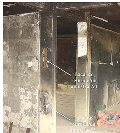
Figura 6 - Pilar P2 após a retirada das amostras A3 e A4
