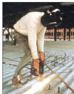
FIGURA 3. Instalação de stud bolts.
