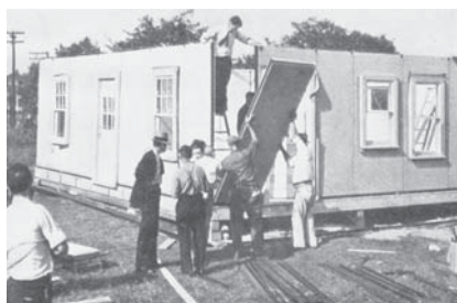
De 1938 - Montagem de casa pré-fabricada com painéis de paredes (USA)
