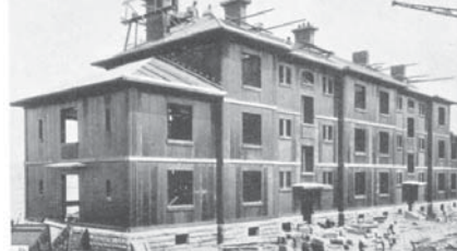
De 1936 (70 anos) Seqüência de montagem do Conjunto residencial executado em 120 dias
