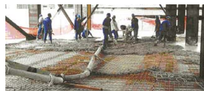
FIGURA 4. Etapas construtivas da laje mista.
