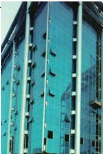
Foto: Revista Construção Metálica 23
