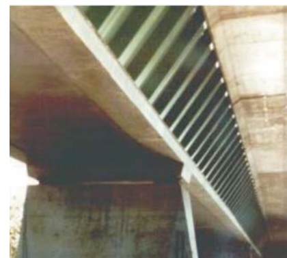
Figura 3: Cognac Bridge (França) Fonte: Wang (2003)
