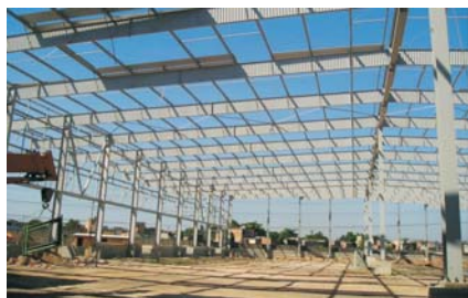
Figura 5 – Galpão Pavuna da Cebel Empreendimentos (Brasil) - Fonte: Acervo Codeme Engenharia
