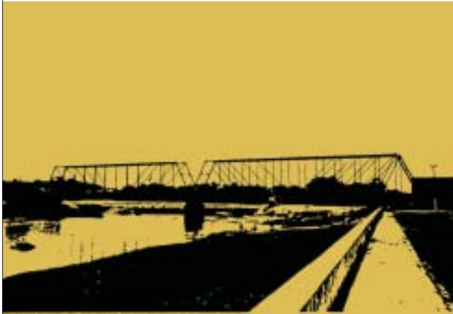
Ponte de Quixeramobim
