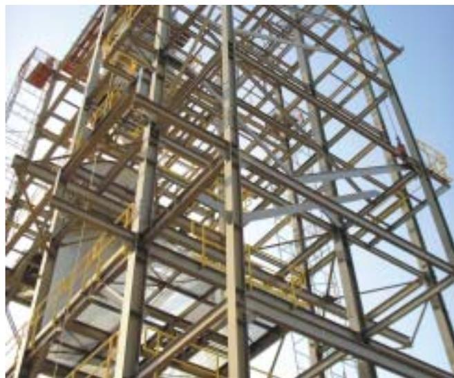
coerentes com os equipamentos por ela suportados. As cores: cinza-chumbo para as vigas, colunas e contraventos; amarelo para guarda-corpos e corrimãos e preto para os pisos em chapa xadrez, propiciaram destaques harmônicos de cada um desses conjuntos, ao mesmo tempo em que as grades alveolares galvanizadas dos pisos e degraus permitiram uma visão transparente de todos eles em cada andar.
