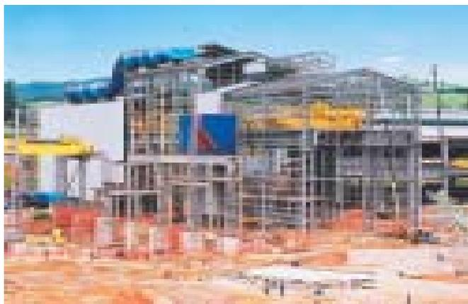
A Icec forneceu e montou 2.000 toneladas de estruturas metálicas na ampliação da Unidade Siderúrgica de Araçariguama (SP), fabricadas de acordo com os padrões de qualidade exigidos pela Gerdau. Este fornecimento está em conformidade com o "Sistema de Garantia de Qualidade baseado na NBR ISO 9001:2000, certificado nº 135703, em agosto de 1997, pelo BVQI.
