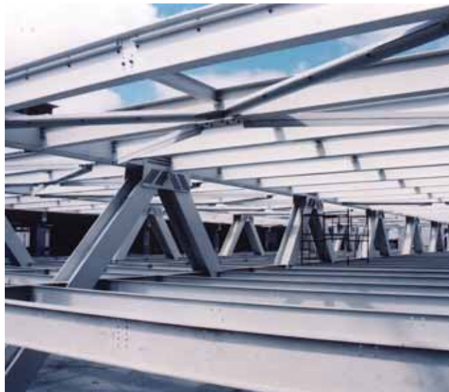
Foto: Arquivo Brafer Construções Metálicas
