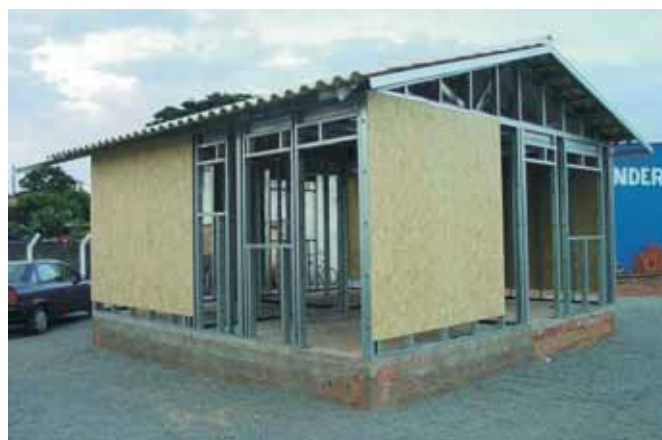
Figura 7 – Engradamento e plaqueamento externo
