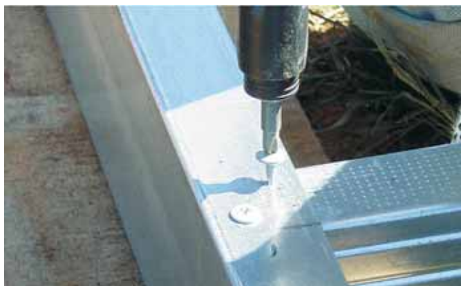
Figura 6 – União entre perfis de LSF
