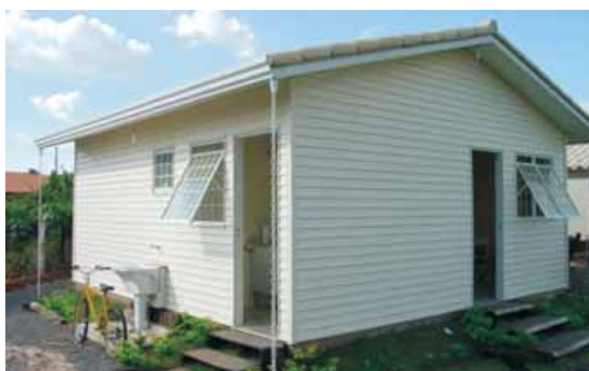
Figura 9 – Residência em LSF
