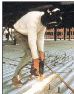
FIGURA 3: Instalação de stud bolts.
