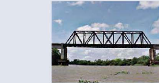
Figura 1 – Vista lateral da ponte metálica
