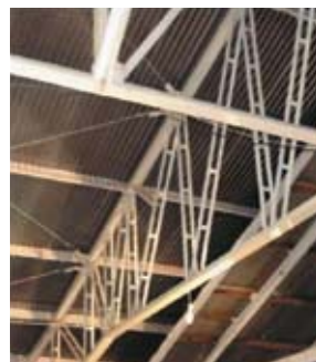
FIGURA 1 Exemplos de treliça com perfis compostos com travejamento em quadros
