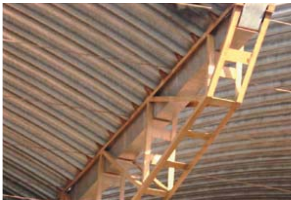
FIGURA 1 Exemplos de treliça com perfis compostos com travejamento em quadros
