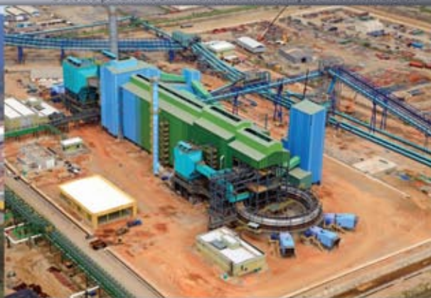
Outotec para TKCSA - Planta de sinterização - 9000 toneladas
