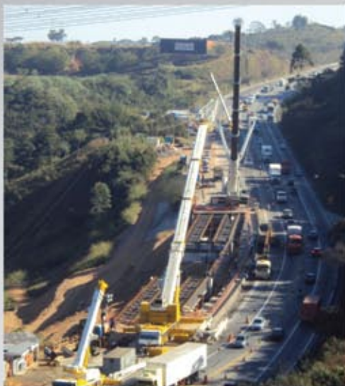
Ponte na CCR Nova Dutra - 300 toneladas
