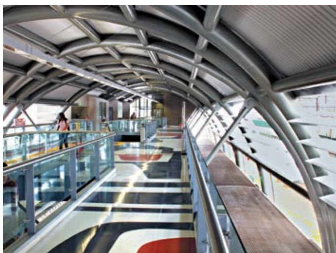
FIGURA 2: Estação Cidade Nova no Rio de Janeiro - tubos curvados por indução eletromagnética. Fonte: Sidnei Palatnik, 2010.
