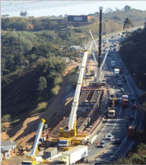
Ponte na CCR Nova Dutra - 300 toneladas
