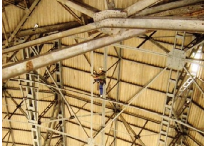
FIGURA 2: Empresa especializada executando inspeção em estrutura de aço (Fonte: Safe Climb Alpinismo Industrial).
