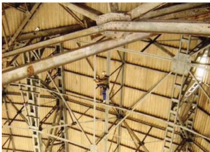
FIGURA 2: Empresa especializada executando inspeção em estrutura de aço (Fonte: Safe Climb Alpinismo Industrial).
