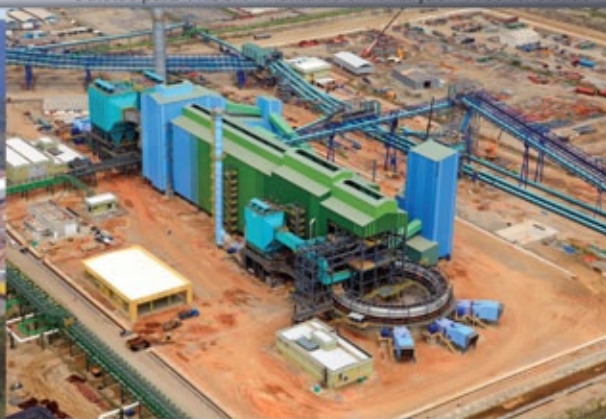
Outotec para TKCSA - Planta de sinterização - 9000 toneladas
