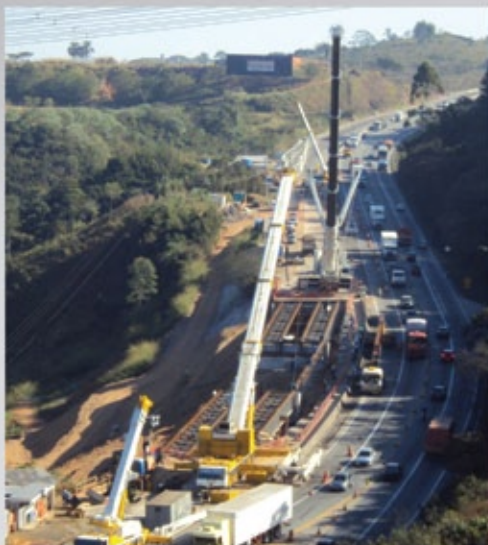
Ponte na CCR Nova Dutra - 300 toneladas
