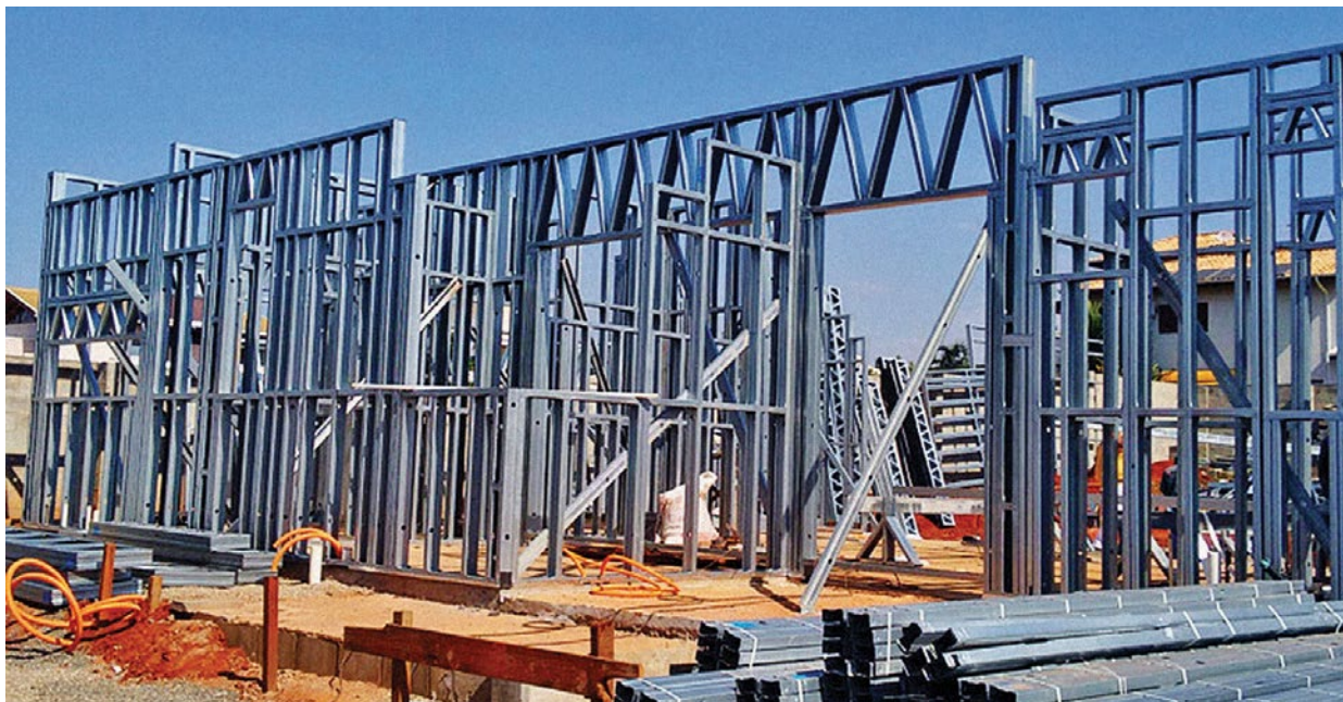
Figura 1: Obra em LSF
