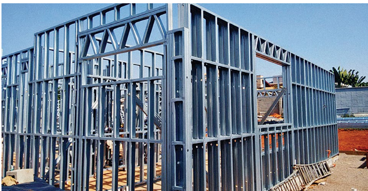
Figura 2: Obra em LSF
