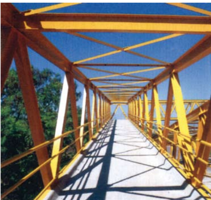
Foto: Divulgação Sidertec Estruturas Metálicas Ltda
