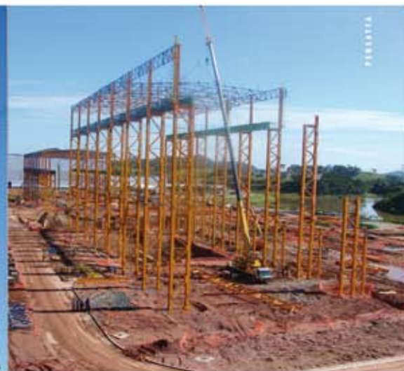
ARCELOR MITTAL VEGA São Francisco do Sul - SC - 3.000 toneladas
