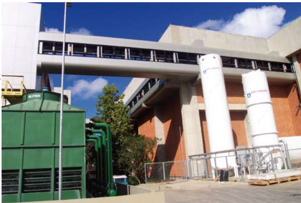
Foto: Divulgação Sidertec Estruturas Metálicas Ltda
