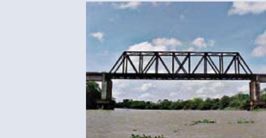
Figura 1 – Vista lateral da ponte metálica
