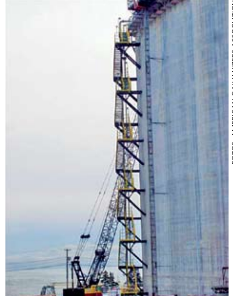
Canaport Protegida pela galvanização a fogo em um ambiente susceptível à corrosão
