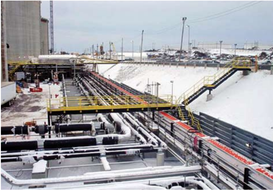
Canaport Protegida pela galvanização a fogo em um ambiente susceptível à corrosão
