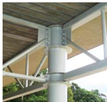
Exemplos de ligações utilizando perfis tubulares (Fonte: Arquivo pessoal)
