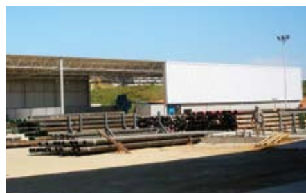
Galpões de inspeção
